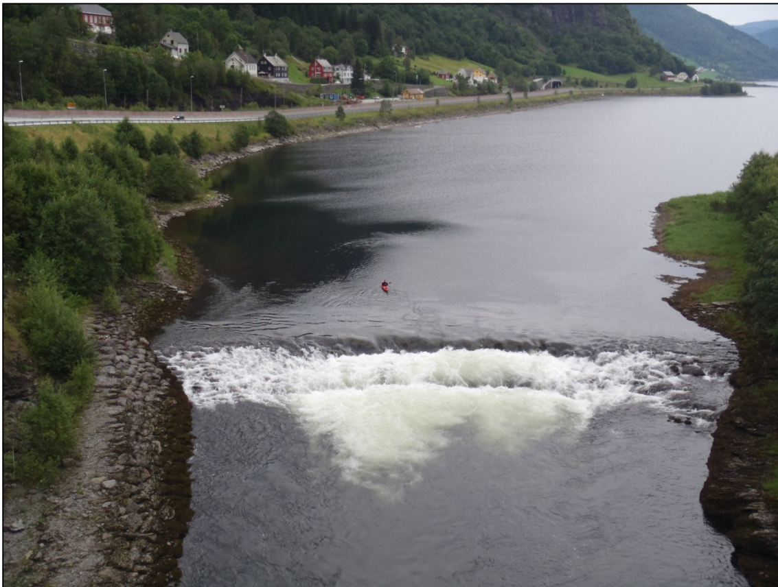
Figur 2. Utløpsterskel Lilandsosen under oppmåling med Leica Tachymeter og Ekkolodd fra kajakk i 2011. Gyteplassen ble restaurert 2014 ca. fra kajakken og oppover mot Vangsvatnet.
