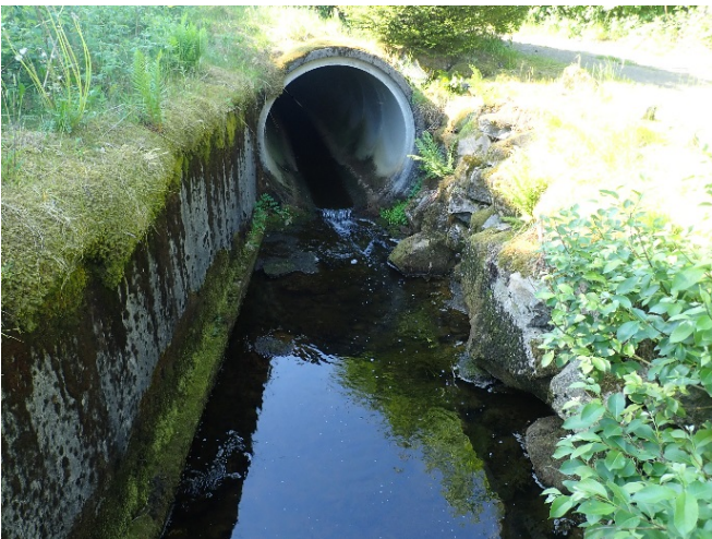
Flere steder er beken lagt i rør eller kulvert. Disse bør ikke være hengende og det bør lages strukturer inne i de.
