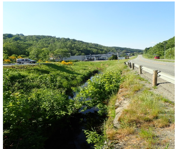
I øvre del er bekken lukket og går under et industriområde.
