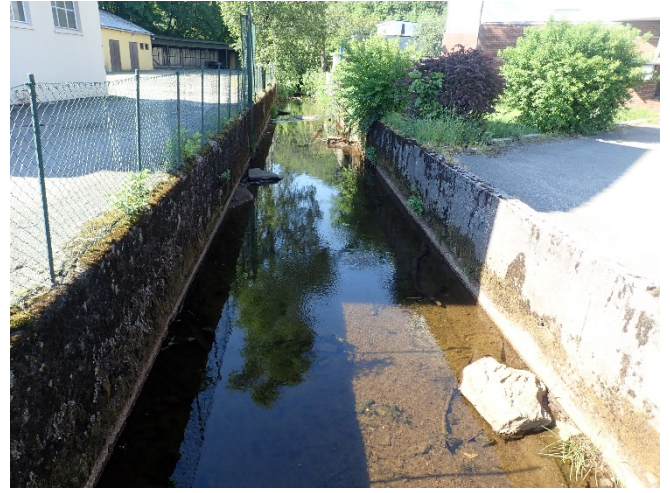
Visse steder er bekken støpt og er uegna for fiskeproduksjon.
