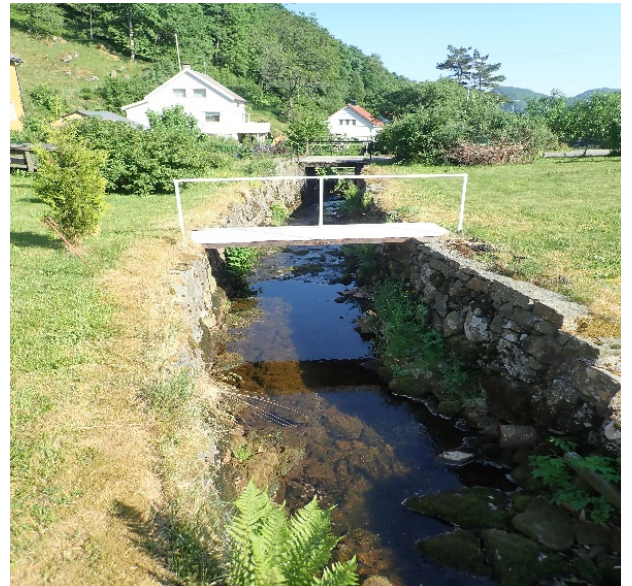
Bekken er senket og flomsikret enkelte steder.
