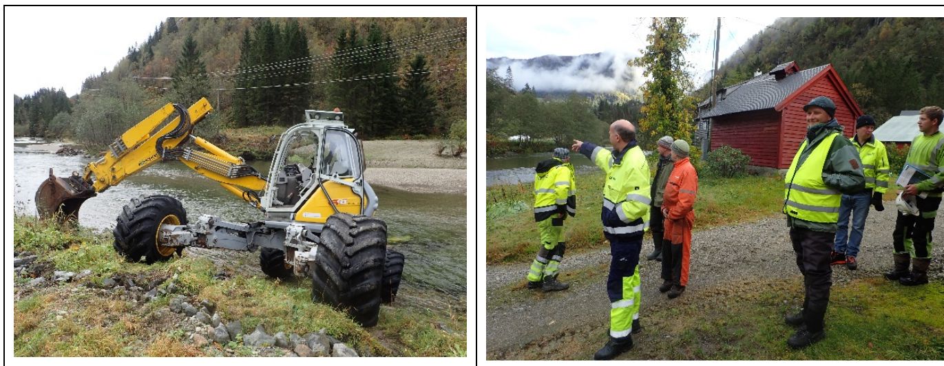
Menzi muck (venstre) ble benyttet til deler av utlegging av stein og blokk grunnet mye vann. En gjennomgang med grunneiere under gjennomføringen av tiltakene var viktig.
