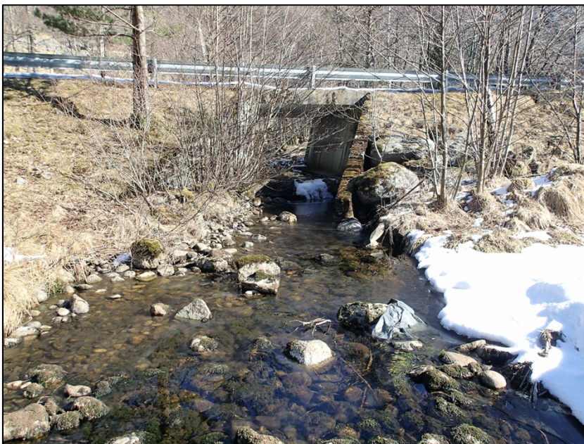
Foto 6: Kulvert i bekk ved Sagjå, før utbedring av kulpen nedenfor.
