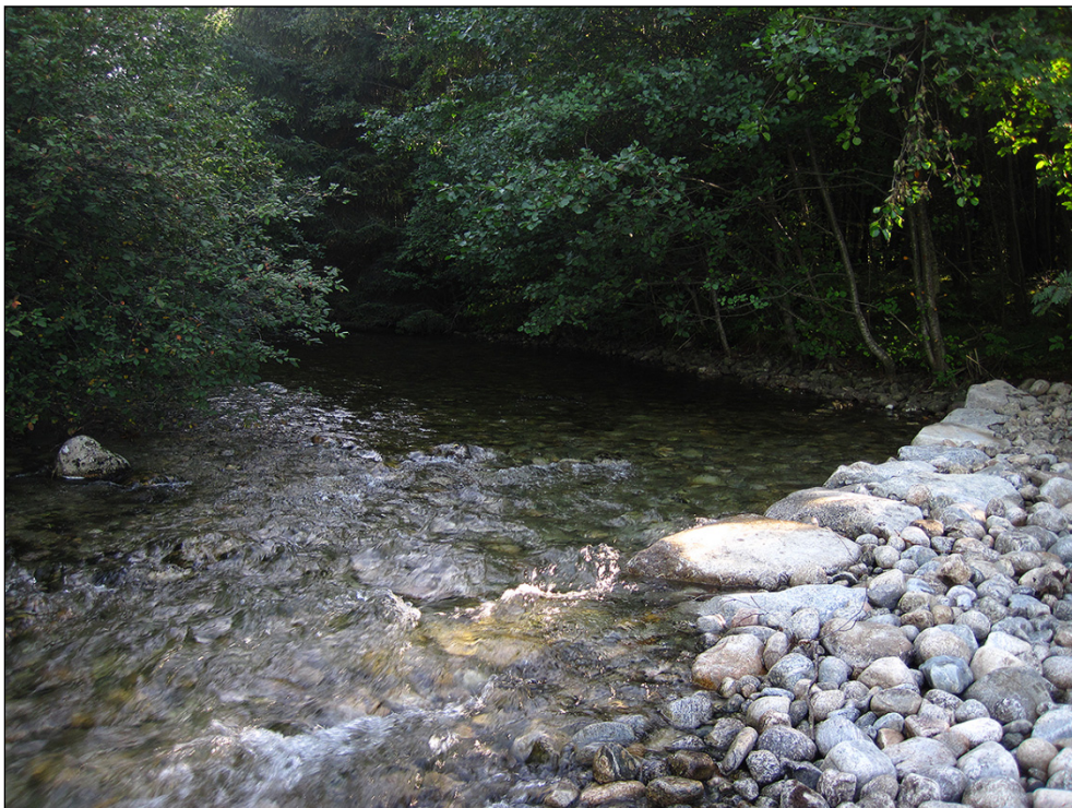
Foto 9: Gjennomført tiltak i form av ledebune i nedre del av Schmidt-åna.
