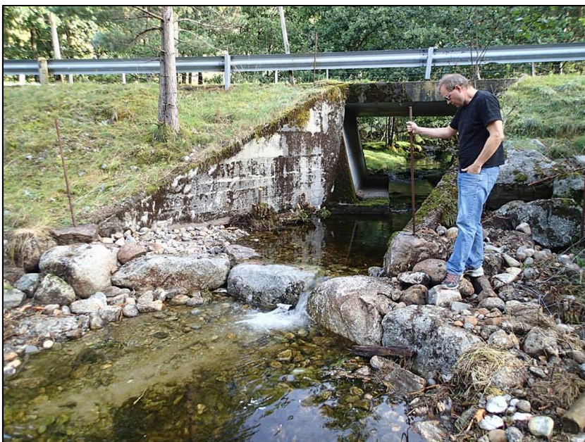
Foto 7: Kulvert i bekk ved Sagjå, etter tiltak.
