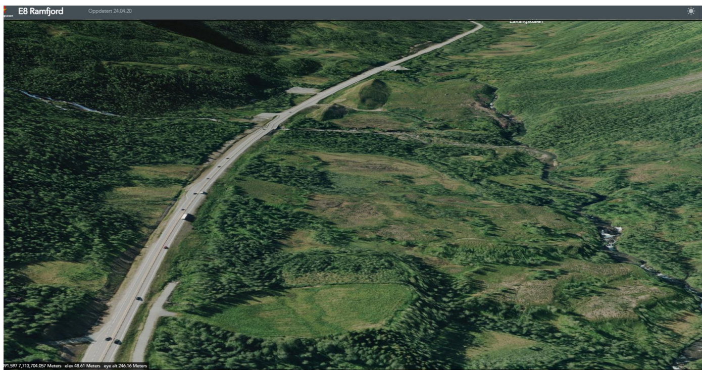
Figur 11. Reingjerde vest for E8 i Lavangsdalen, sett nordfra. Skredvoll til høyre for vei, bak i bildet (Statens Vegvesen).
