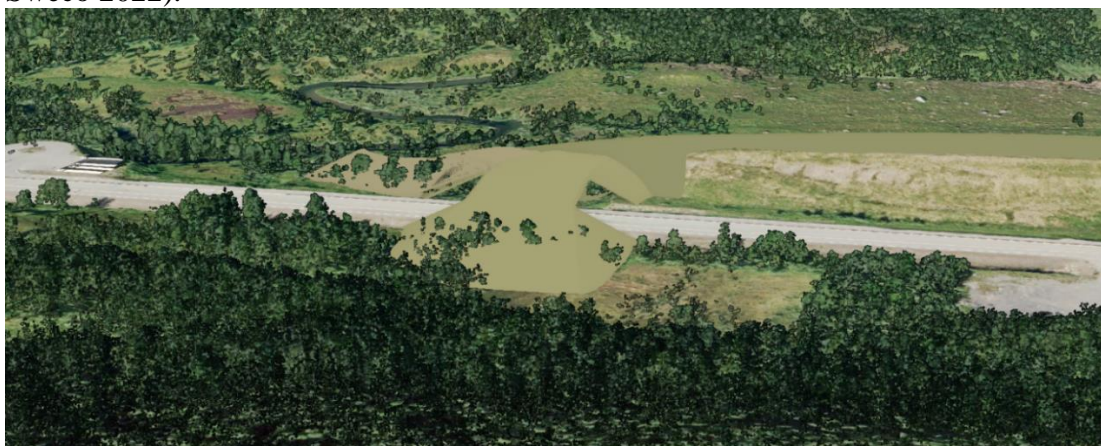
Figur 18. Reinovergang sett mot vest (Statens Vegvesen).
