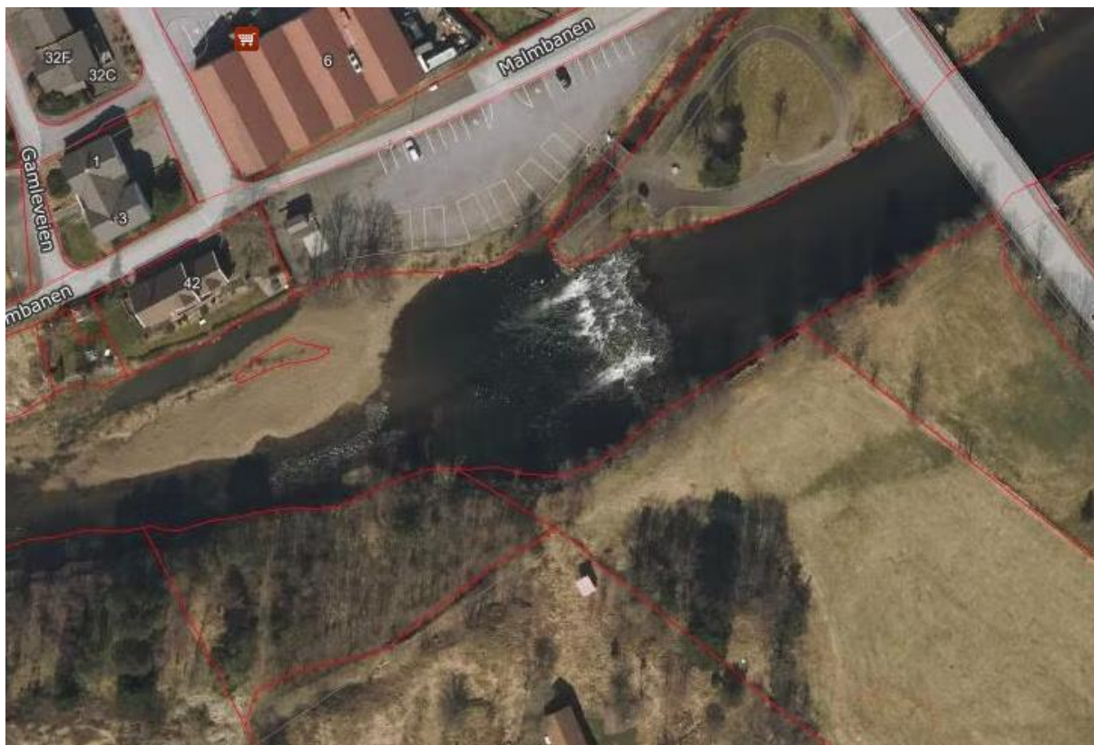
Figur 59. Terskelen ved like nedstrøms kommunehuset. Denne terskelen bidrar til å sikre broen der Årstadveien krysser Sokna. Terskelen er imidlertid stor og kan justeres særlig med tanke på vandringsforhold for fisk på lave vannføringer. Det beste helhetlige alternativet for både flomhåndtering og fiskehabitat vil være å skifte ut broen og fjerne terskelen (foto: www.finn.no/kart ).
