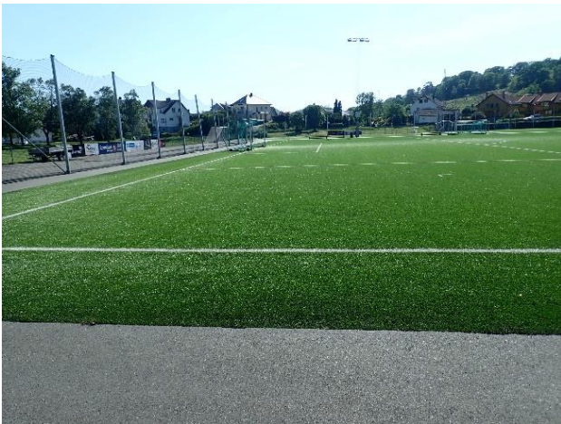
Bekken er lagt i rør under idrettsanlegg. Det er usikkert om fisk kan svømme gjennom rørene.
