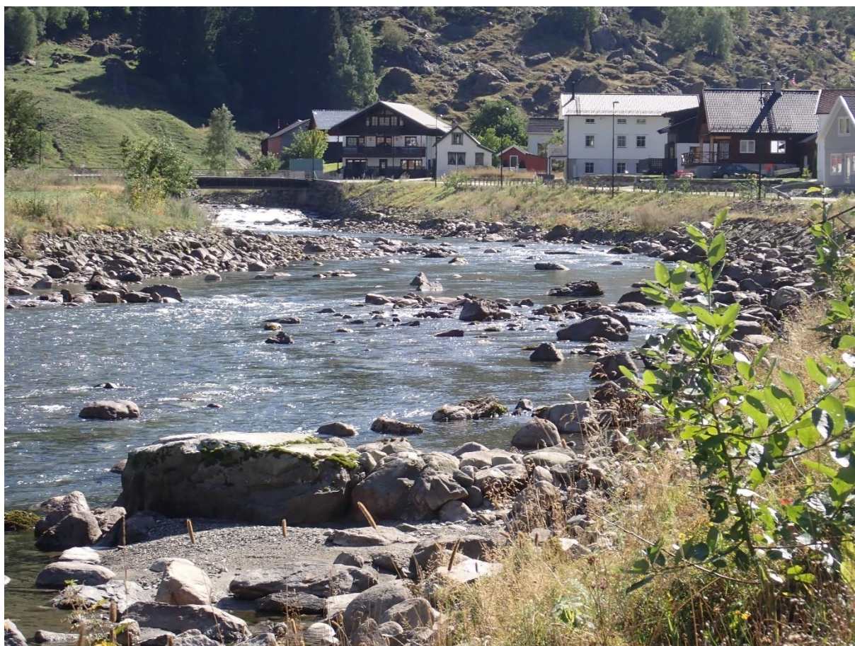
Figur 63. Miljøtilpasset kantsikring (ordna steinlag + steinutlegg + kantvegetasjon) i Flåmselva
