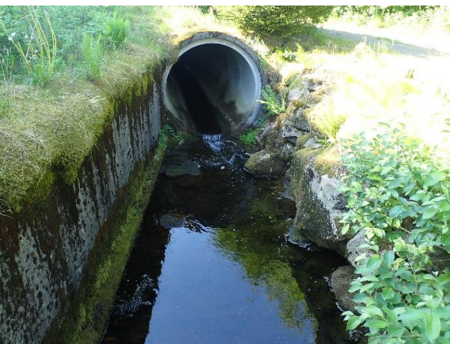
Flere steder er beken lagt i rør eller kulvert. Disse bør ikke være hengende og det bør lages strukturer inne i de.
