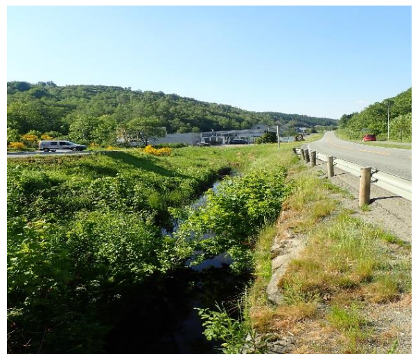
I øvre del er bekken lukket og går under et industriområde.
