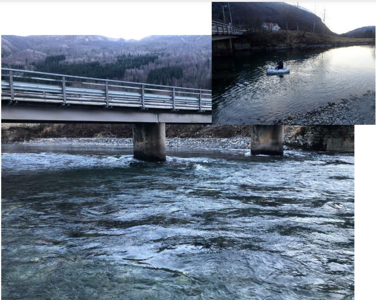
Figur 39: strømforholdene under broen 20.11.2022. Det danner seg et stryk, til sammenligning kulpkarakter før sikringstiltakene (opp til høyre). Bilde tatt av Knut Stauri
