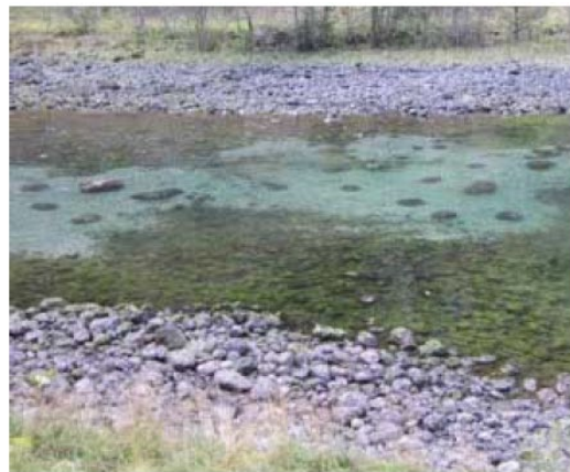
Figur 27: Terskel endret til stryk. Lavvannsrenne i stryket sikrer vannspeil/kulpkarakter oppstrøms.
