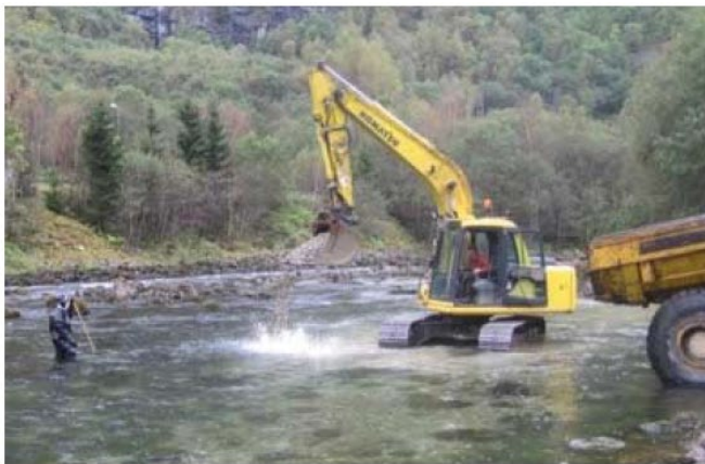
Figur 28. Grusutlegg i Aurlandselva med gravemaskin
