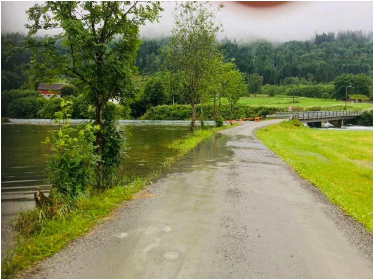
Figur 38: utfylling av kulpen har redusert elvetverrsnittet såpass at det oppstått oppstuvning ovenfor og superkritisk strøm under bruene. Bilde tatt av Stryn elveigerlag
