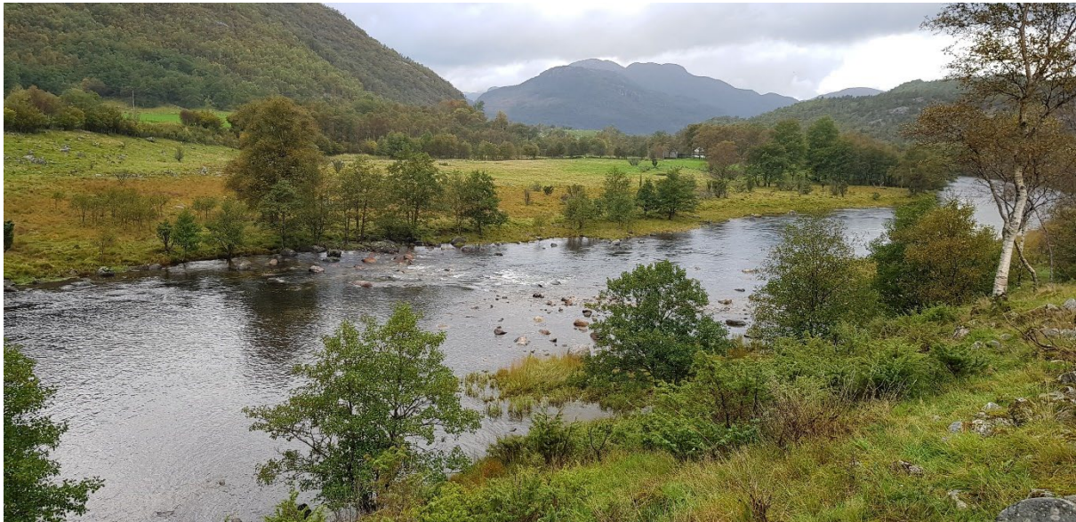
Figur 27: Terskel endret til stryk. Lavvannsrenne i stryket sikrer vannspeil/kulpkarakter oppstrøms.
