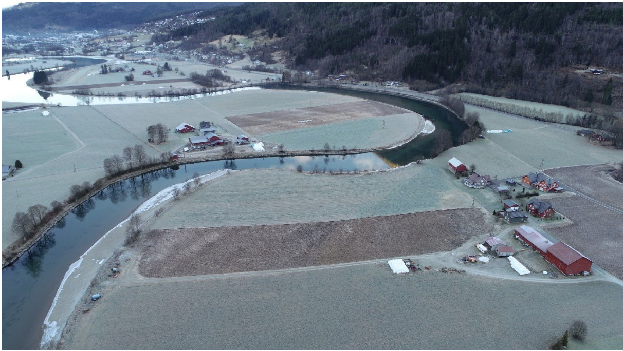
Figur 25. Område i nedre del av Strynseelva med manglende og glissen kantvegetasjon
