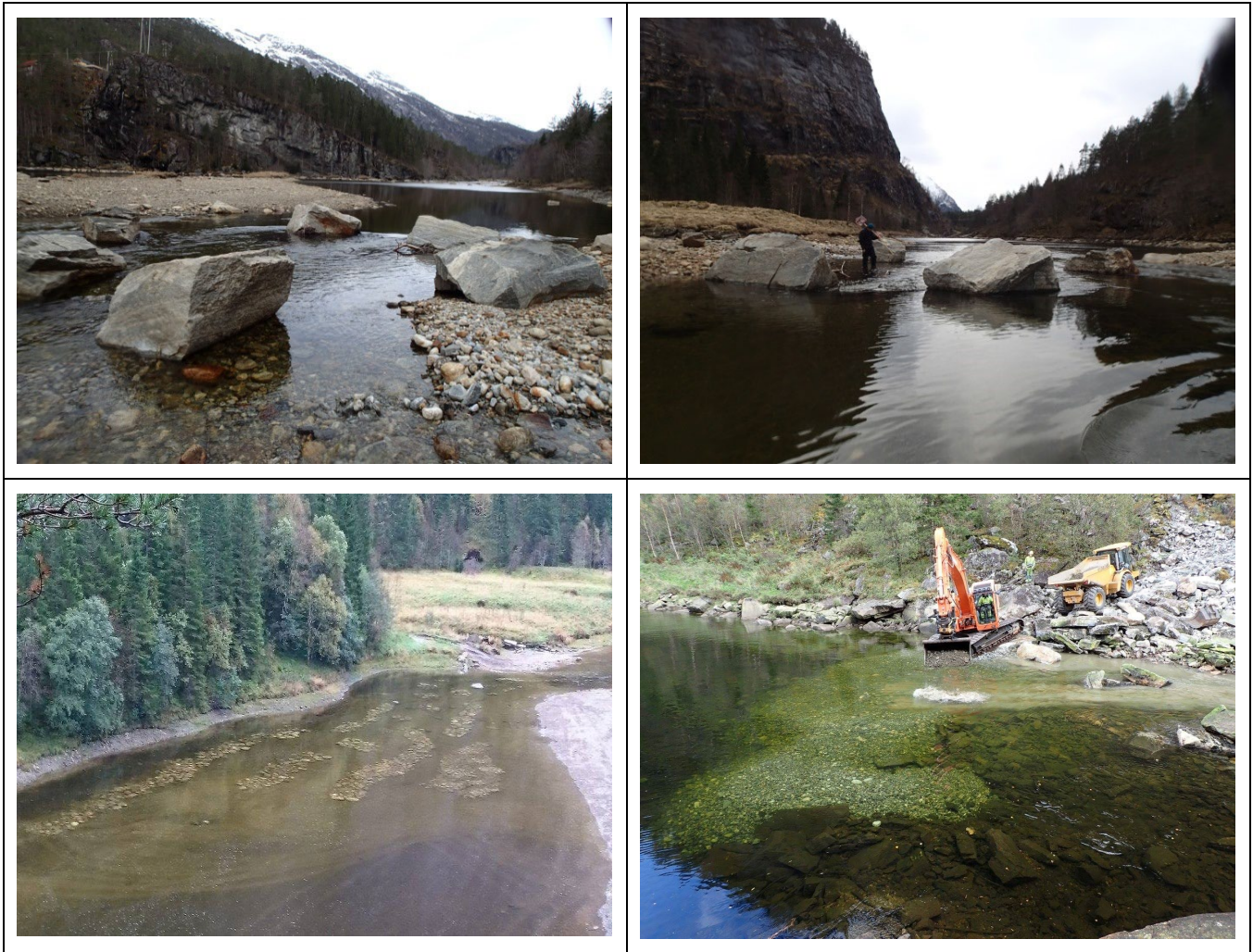
Figur 25. Midt i strekningen var det et smalere sund med egne forhold for gyting. Noen av de store blokkene ble flyttet for å bedre gytemulighetene på dette området. Steinrekkene ble lagt ut oppstrøms sundet og danner hulrom for ungfisk i et område som bar preg av å være et dårlig oppvekstområde. Disse gir også skjul for voksenfisk. Gytegrus ble lagt ut i det området hvor terskelen lå tidligere og området er i dag egnet for gyting.
