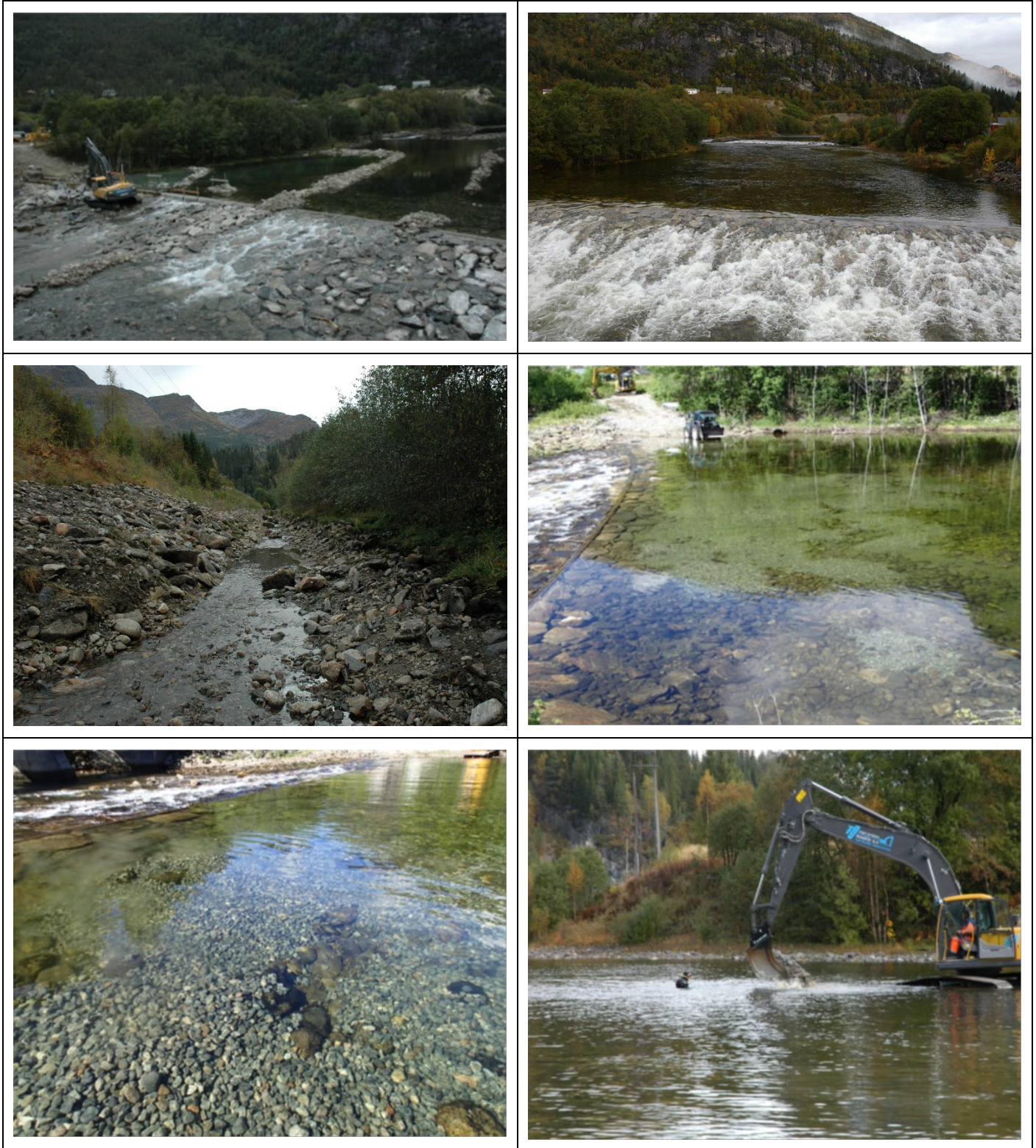
Figur 18. Det ble etablert ny terskel i hovedløpet nedstrøms Myster kraftstasjon i Ekso (øverst) sommeren 2008, og gjort tiltak for å sikre vann i sideløpet som munner ut i terskelbassenget (midten til venstre). I 2013 og i 2014 ble det lagt ut egnet gytegrus i terskelbassenget (nederst).
