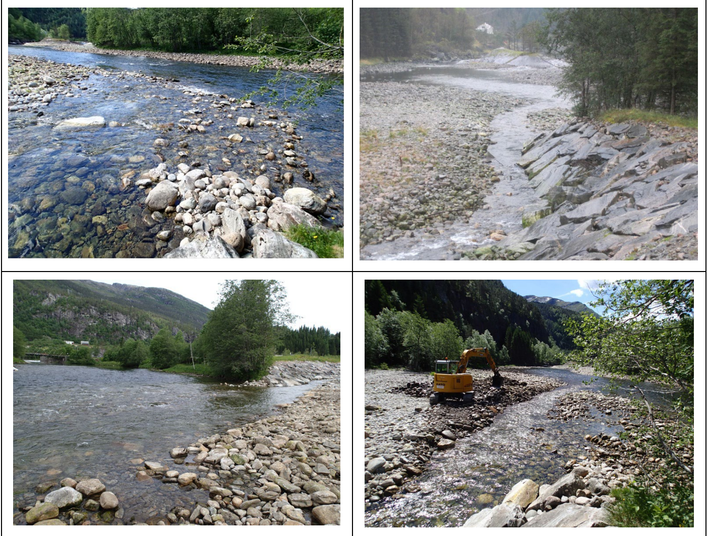
Figur 22. Samløpet mellom Leiro og hovedløpet i Ekso ble utbedret ved å grave en definert dypål inn i Leiro sommeren 2013. Tiltaket har trolig forbedret konnektiviteten for både ung- og voksenfisk mellom hovedløpet og denne sideelven.
