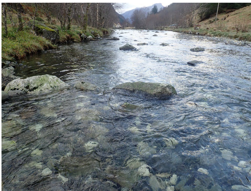
Ledebune med flere større blokker utlagt i Bortneelva for å danne økt hydromorfologisk variasjon
