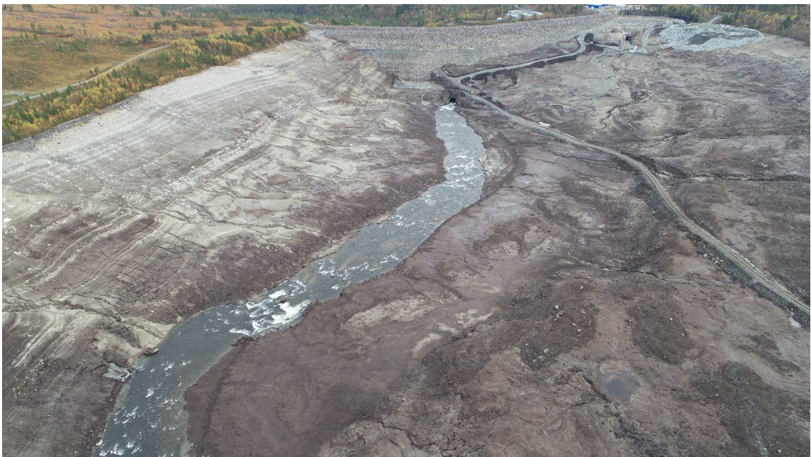
Dammen i Foldsjøen sikres bedre (øverst). I Foldsjøen har vannmassene gravd seg ned i bunnen av innsjøen og dannet en elv. Foto: NORCE LFI (04.10.2022).
