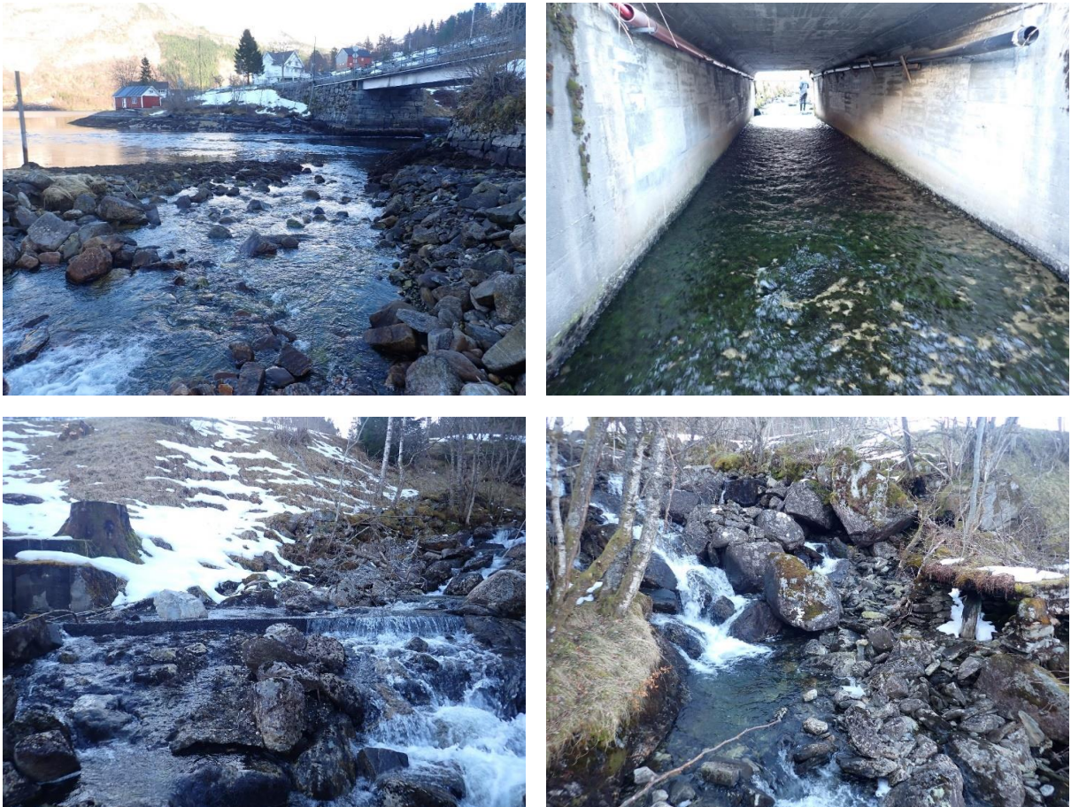
Figur 51. Osen til Straumselva (oppe t.v.), kulvert under nederste vei (oppe t.h.), kunstig temporært vandringshinder (nede t.v.) og naturlig permanent vandringshinder ca. 200 meter fra sjøen (nede t.h.).
