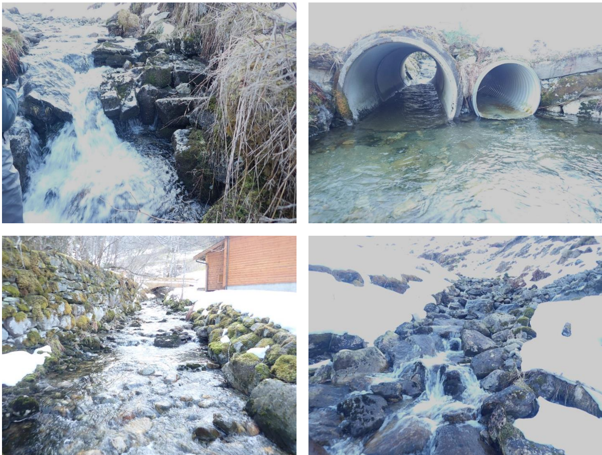
Figur 64. Steinterskel (nederste kunstige vandringshinder) (oppe t.v.), gunstig utformet kulvert under nederste bro (oppe t.h.), forbygninger langs begge elvebredder i nedre del (nede t.v.) og bunnplastring og krevende oppvandringsforhold i øvre del av bekken i Follabugen (nede t.h.).
