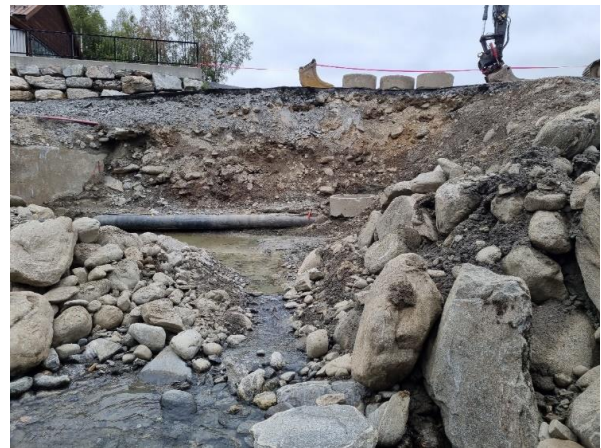
Figur 34. Forbygning langs nedre del av elva (oppe t.v.), tørt flomløp (oppe t.h.), silt/finsedimenter som dekket substratet på rolige områder i elva (nede t.v.) og utslippspunkt for finsedimenter grunnet gravearbeid (nede t.h.).
