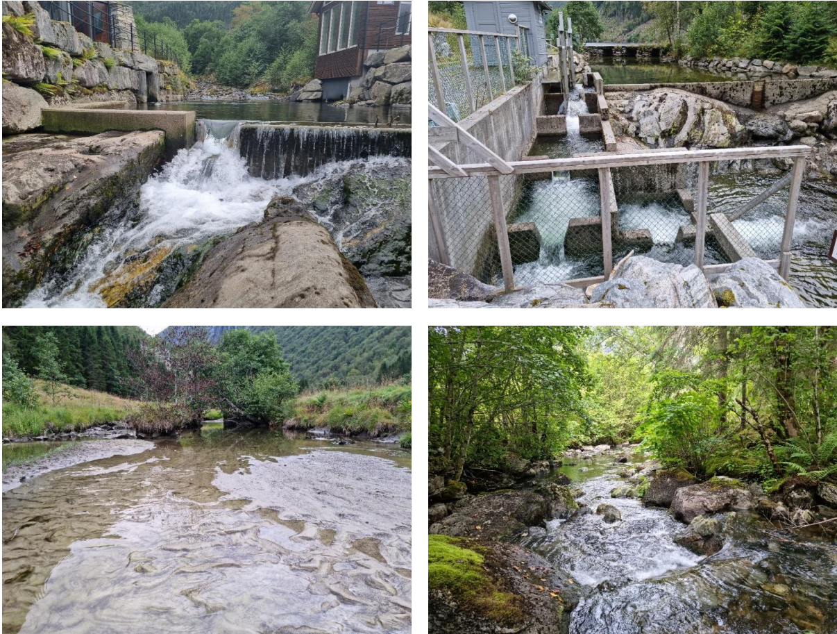
Figur 42. Temporært vandringshindrende inntaksdam i Tungeelva (oppe t.v.), fisketrapp på utløpet av Vassbakkevatnet (oppe t.h.), store mengder finsedimenter fra olivinbruddet i øvre del av Steinsvikelva (nede t.v.) og strykparti med bevart kantvegetasjon (nede t.h.).
