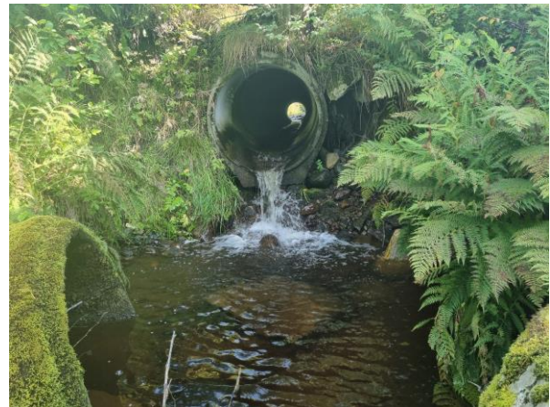
Figur 25. Kunstig temporært vandringshinder i form av betongterskel i nedre del (oppe t.v.), forbygd og kanalisert elvestrekning og mangel på kantvegetasjon (oppe t.h.), mudderaktig belegg på elvebunnen i øvre del (nede t.v.) og det nederste røret på anadrom strekning som fungerer som kunstig vandringshinder (nede t.h.).
