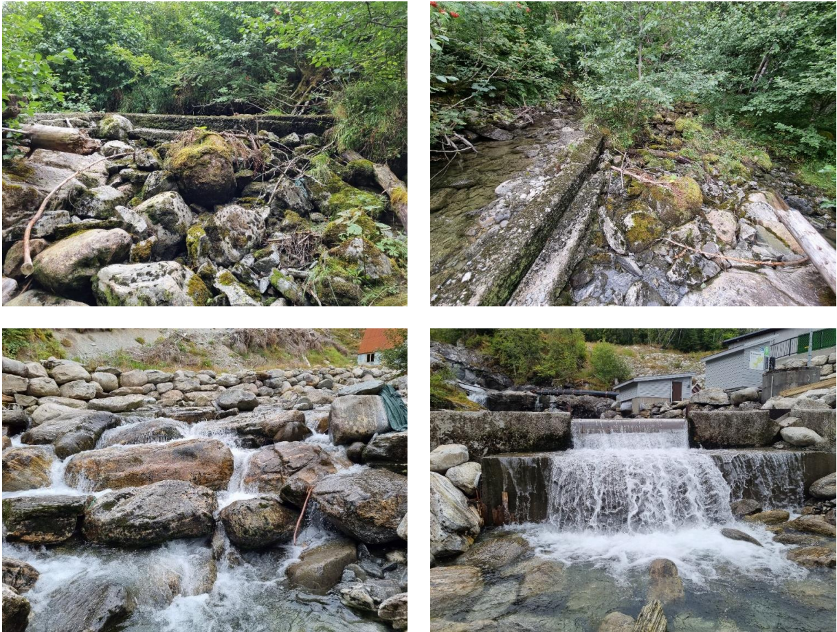
Figur 33. Betongkonstruksjon i sideløp sett fra nord (oppe t.v.) og fra øst (oppe t.h.), terskel av store blokker (kunstig temporært vandringshinder) i hovedelven (nede t.v.) og inntaksdammen til settefiskanlegget (kunstig permanent vandringshinder, nede t.h.).
