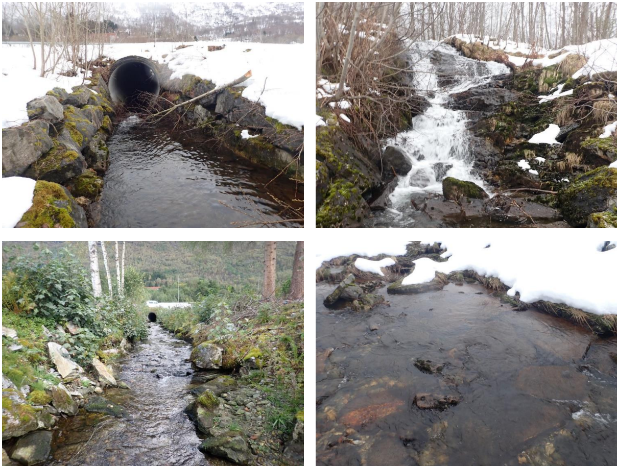
Figur 73. Røret som er kunstig temporært vandringshinder (oppe t.v.), naturlig permanent vandringshinder i det ene løpet (oppe t.h.), forbygd elvestrekning hvor store deler av kantvegetasjonen er hogget (nede t.v.) og bunnplastring i øvre del av elva (nede t.h.).
