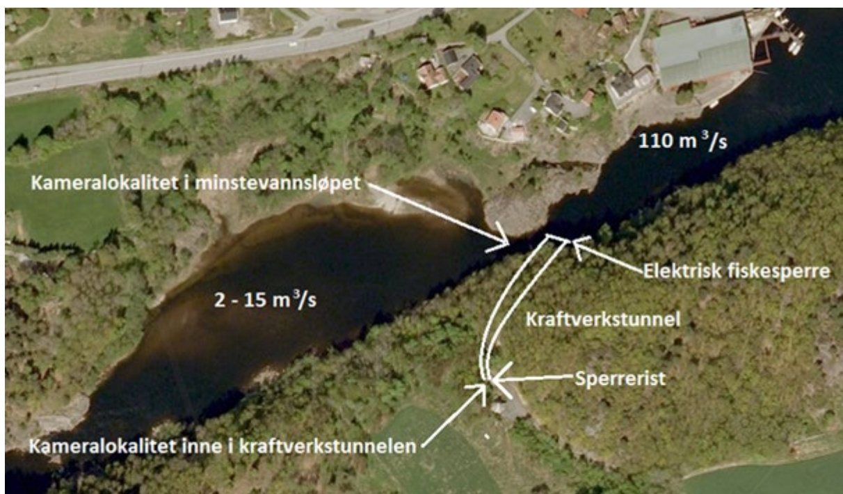
Videoovervåkingslokalitet ved utløpet av kraftverkstunnelen fra Rygene kraftverk i Nidelva i 2014.
