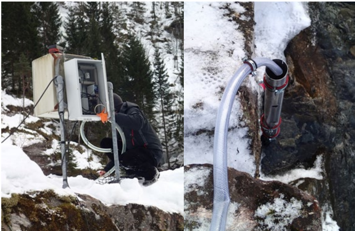
Oppsett av gassloggingsutstyr (her i Modalselva, Nordhordland). Sonden ligger i et perforert rør som vist på bildet til høyre.
