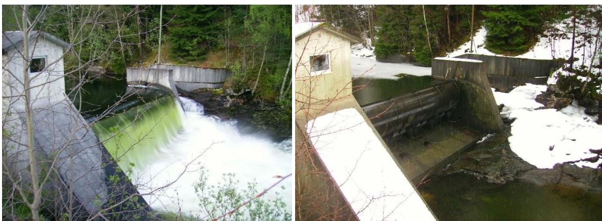
Fangdammen til kraftverket ved høg og lav vassføring. Det viser seg at fella fanga godt med smolt opp mot 70-80 m 3 /sek. Når elva vart større gjekk nok mange smolt i overløpet over fangdammen.
