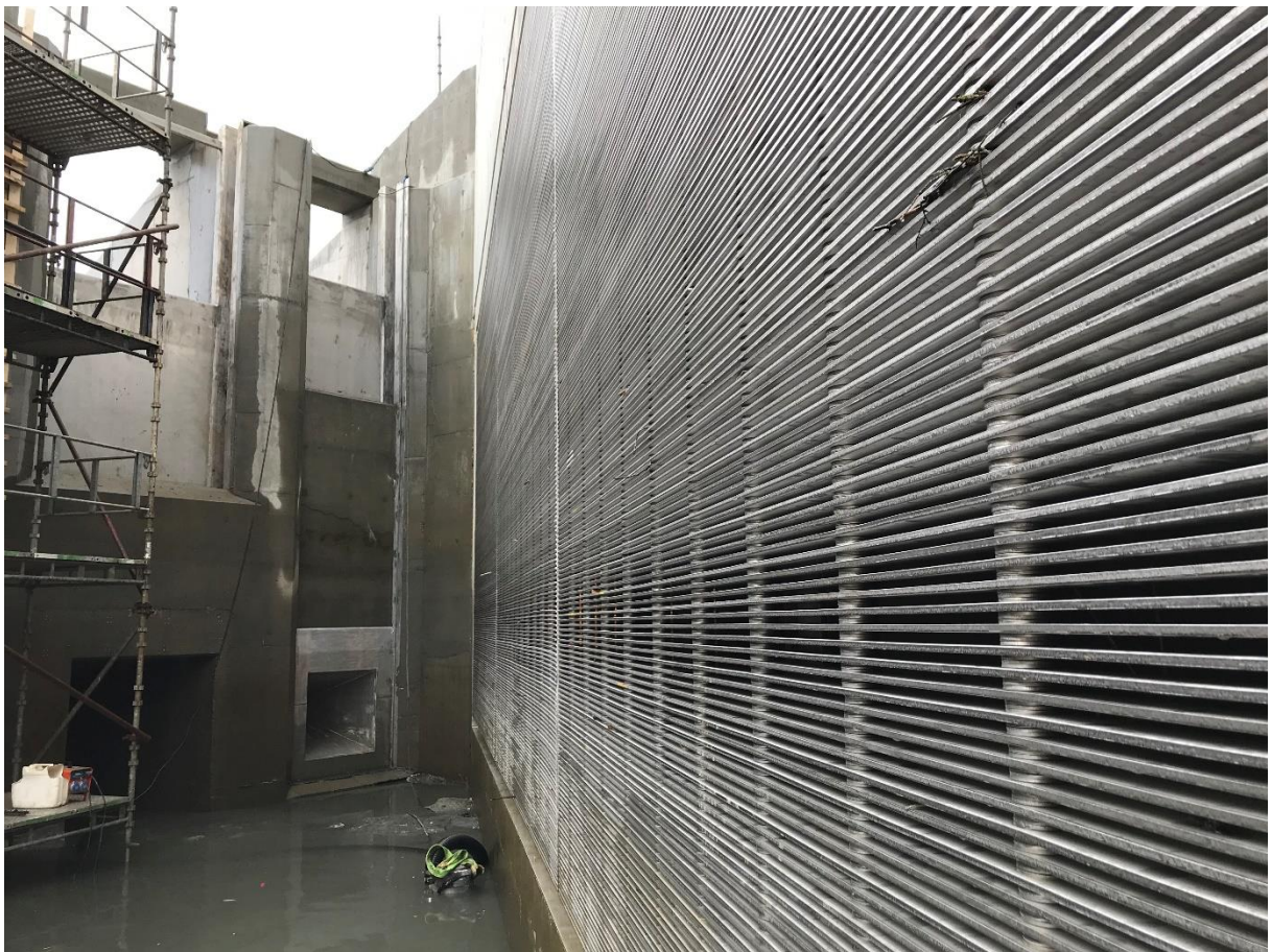
Finmasket varegrind med overflate- og bunnluke i bakgrunn (Foto: NORCE LFI v/Ulrich Pulg).
