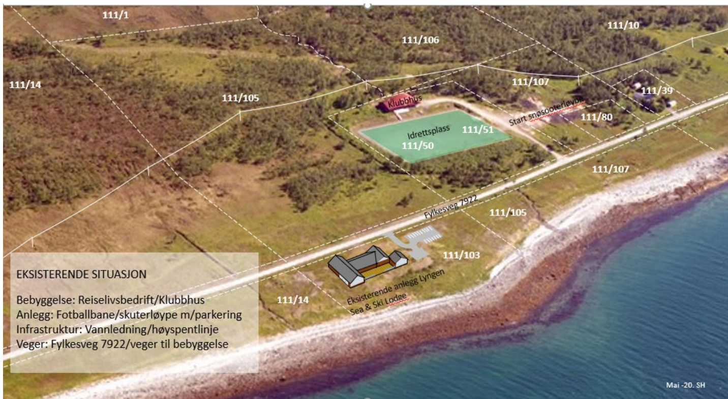
Figur 38. Eksisterende situasjon i utbyggingsområdet (Høgtun 2020).
