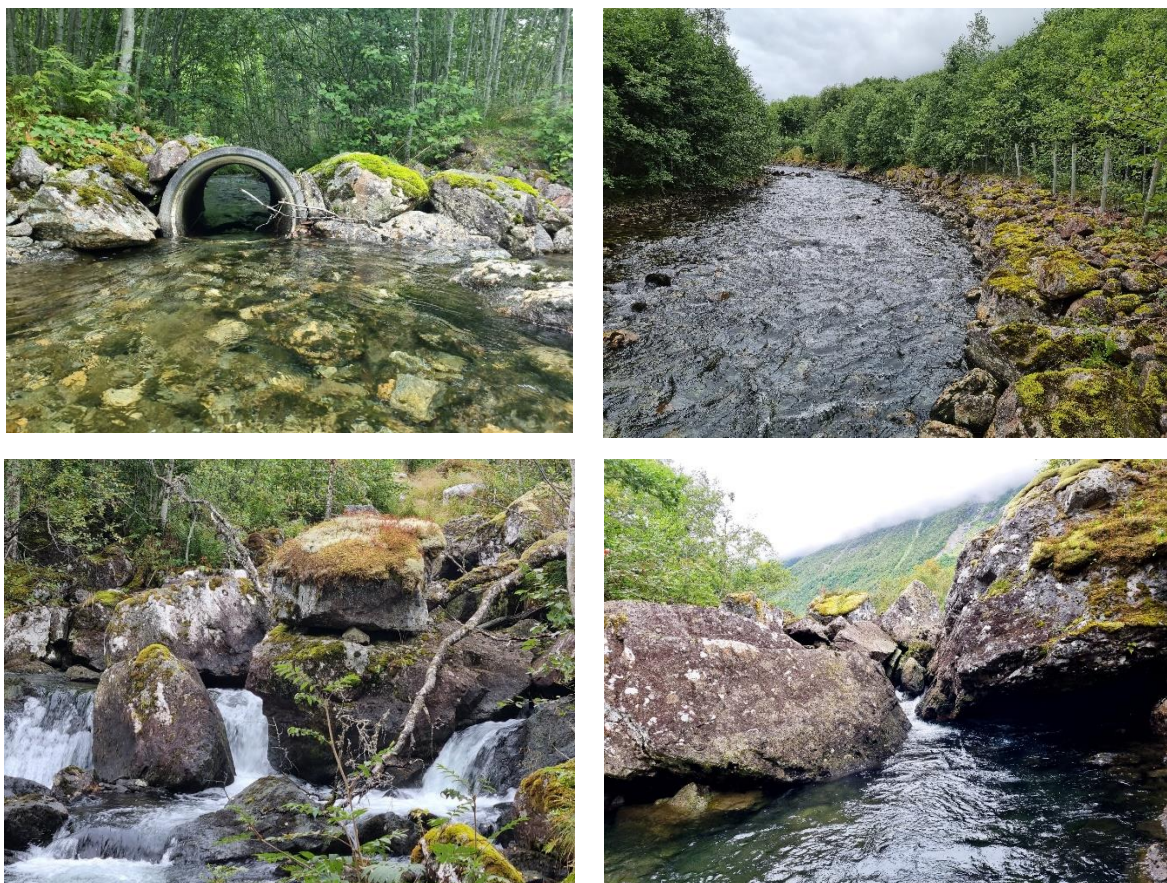
Figur 17. Øverst: Innløp til det lange sideløpet nord i segment 2 gjennom kulvert (venstre) og erosjonssikring like oppstrøms den samme kulverten (høyre). Nederst: Vandringshinder i det nordligste elveløpet (venstre) og vandringshinder i det sørligste elveløpet (høyre).
