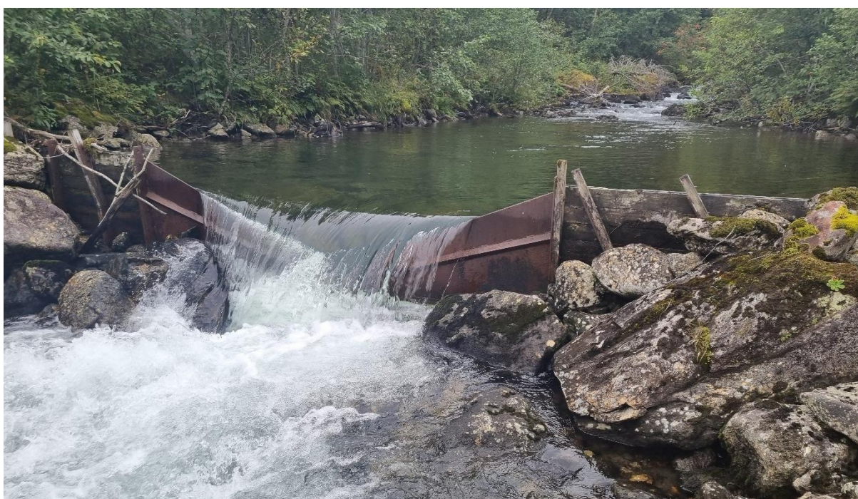
Figur 18. Terskel i det nordlige sideløpet som fungerer som sedimentbasseng og dermed har en oppstuingseffekt på sedimenter.
