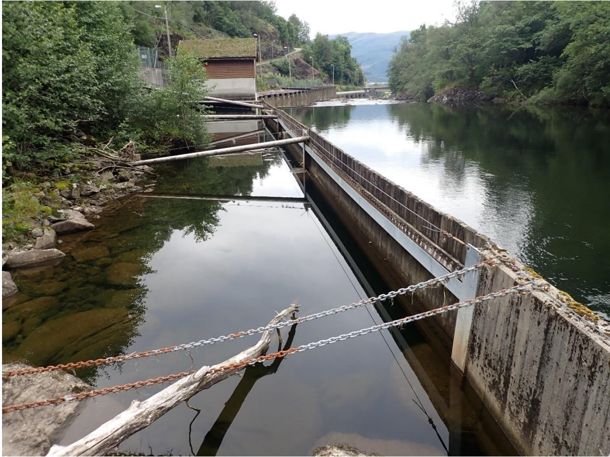
Figur 51. Skillevegg for å hindre fisk i å gå inn i inntaket til kraftverket i Tysseelva.
