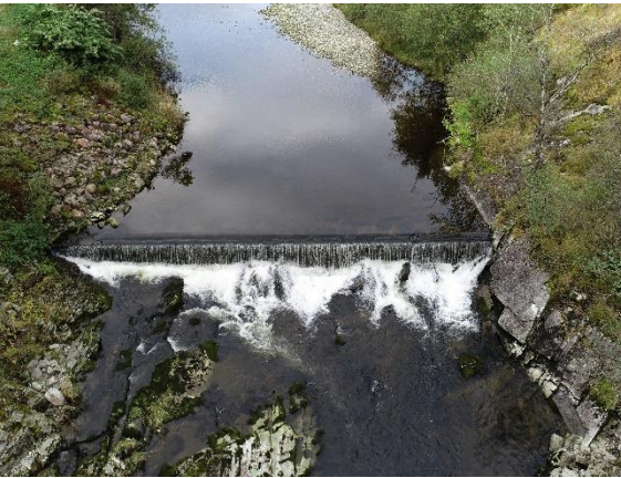
Figur 20. Oppvandingsterskler i betong i juvet nedenfor Langeland (oppe t.v. og oppe t.h.), betongterskel på Langeland som fungerer som temporært kunstig vandringshinder (nede t.v.) og erosjonssikring som har rast ut på Langeland (nede t.h.).
