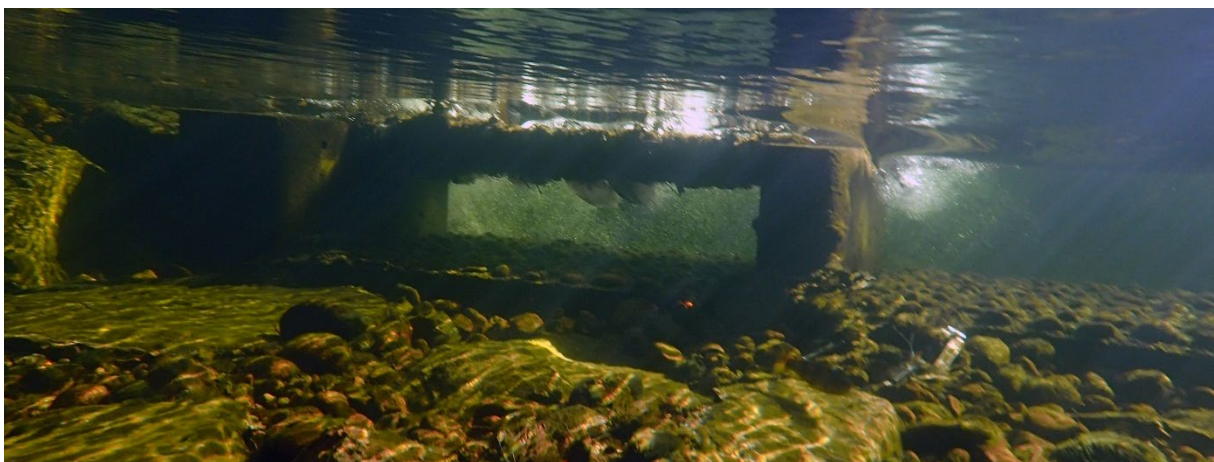
Inntaket til blekeløpet hvor kamera er plassert på høyre side.
