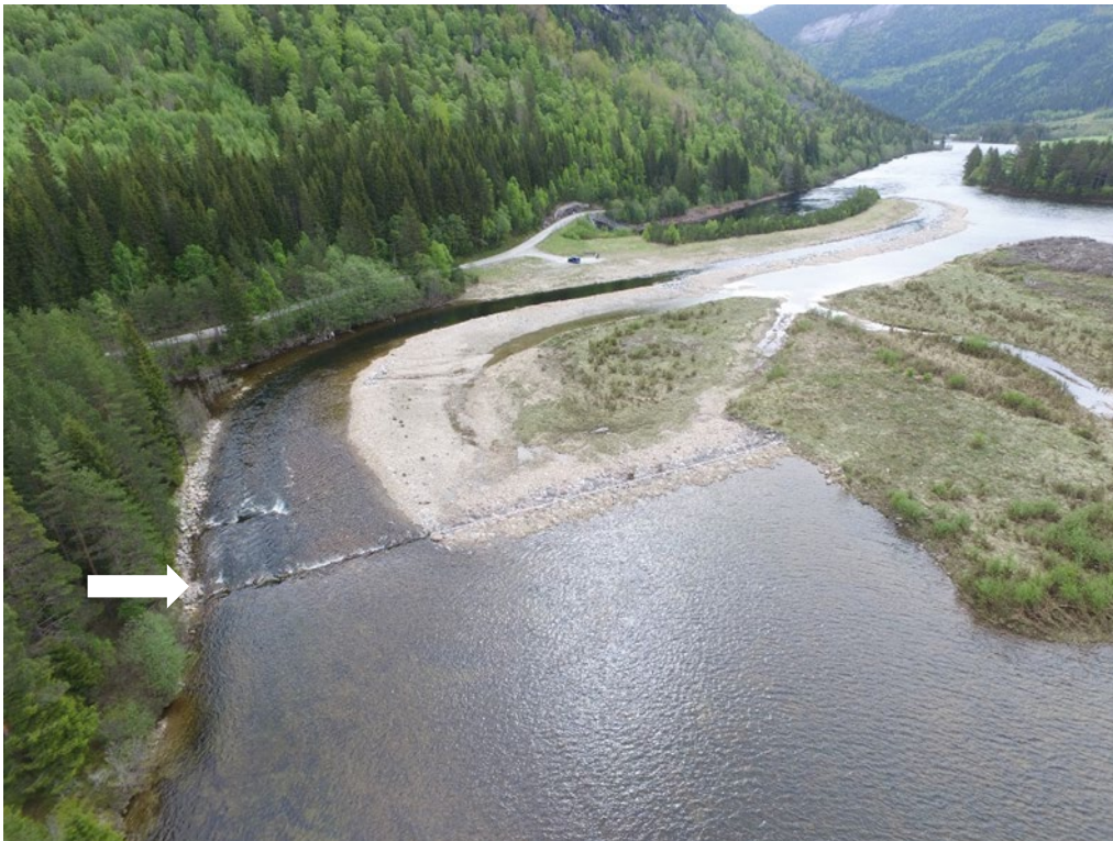
Foto som viser innløpet av Blekeløpet før samløp med hovedløpet nedstrøms utløpet av Hekni kraftstasjon. Pilen viser plasseringen av kamera for registrering av vandrende fisk.
