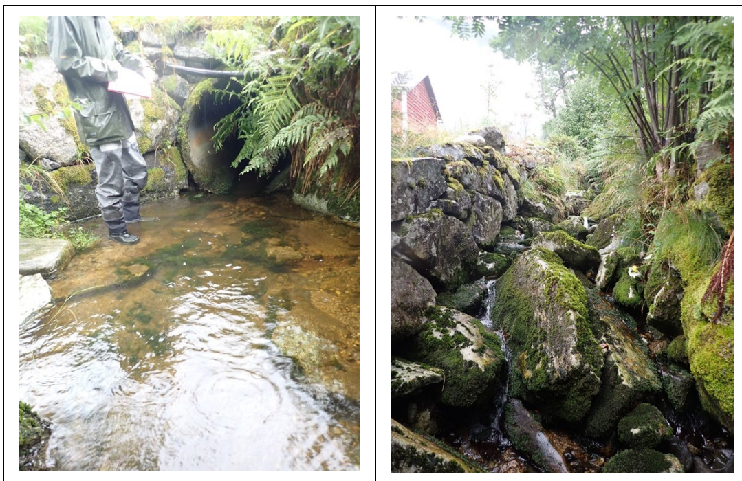
Bunnplastring rett nedstrøms øvre terskel (t.v). Øvre del av bekken består av små kulper med bratte strykområder og store blokker; vanskelige oppvandringsmuligheter for sjøaure (t.h).
