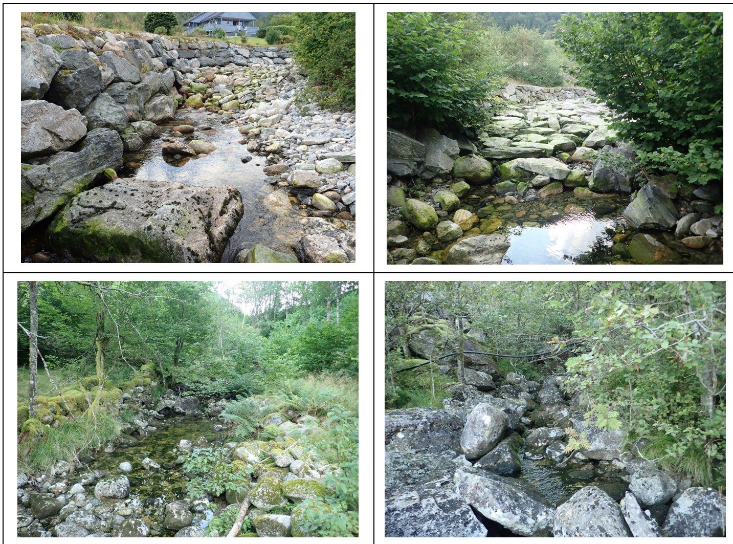
Bekk ved Nordrevik er sterkt forbygd grunnet landbruk og en lang strekning har bunnplastring der den krysses av E 39.
