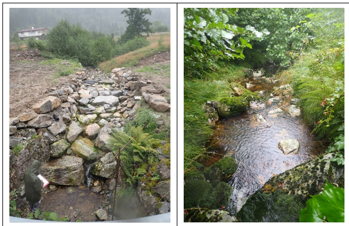
Bunnplastring som fungerer som permanent vandringshinder (t.v). Øvre del av bekken består av små kulper med bratte strykområder (t.h).
