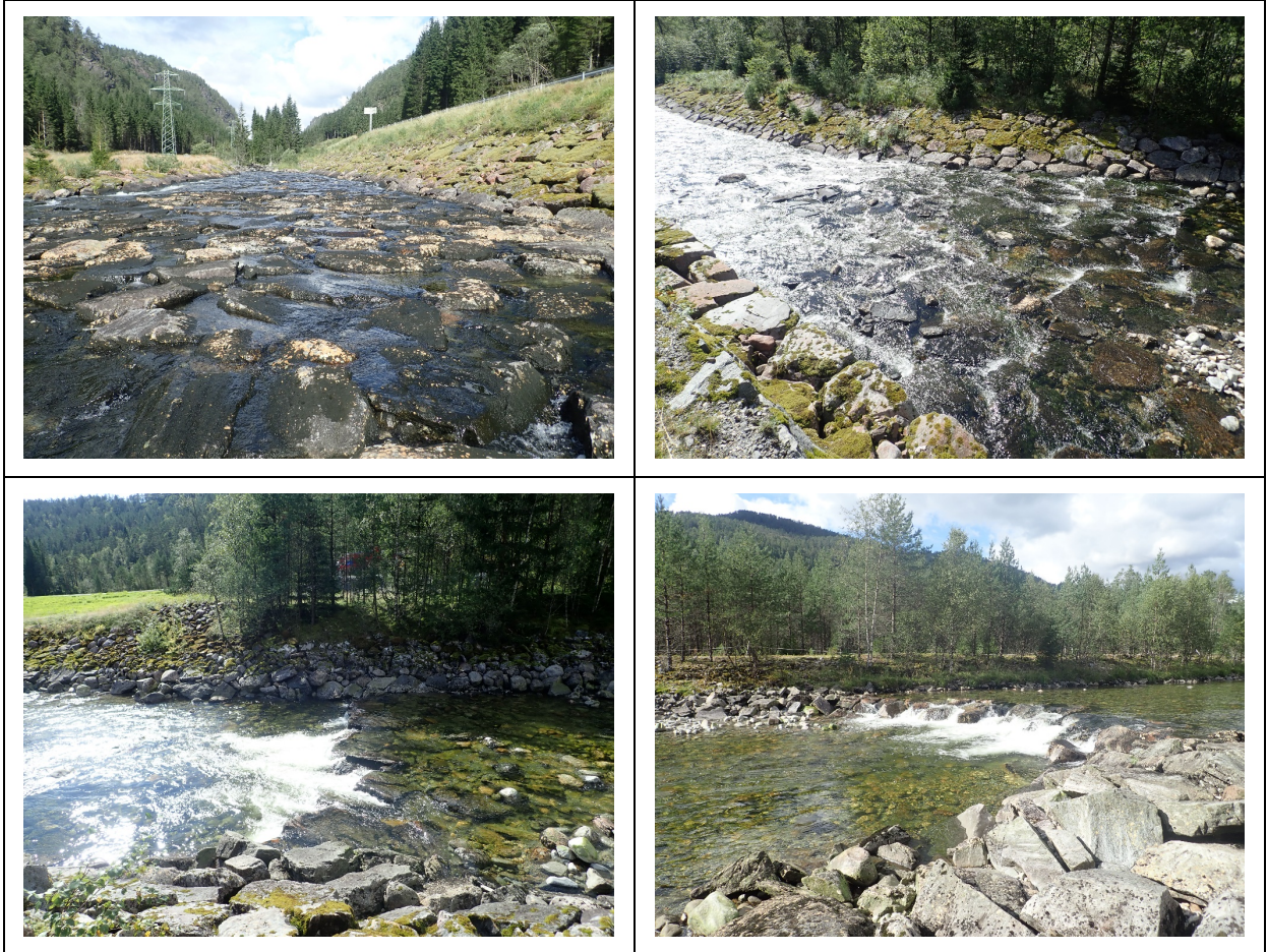
Romarheimselva er plastret og bunnsikret i midtre deler, og det finnes både kantsikring og en rekke terskler i nedre deler av elva. Forbygningene har trolig negativ effekt på fiskeproduksjonen.
