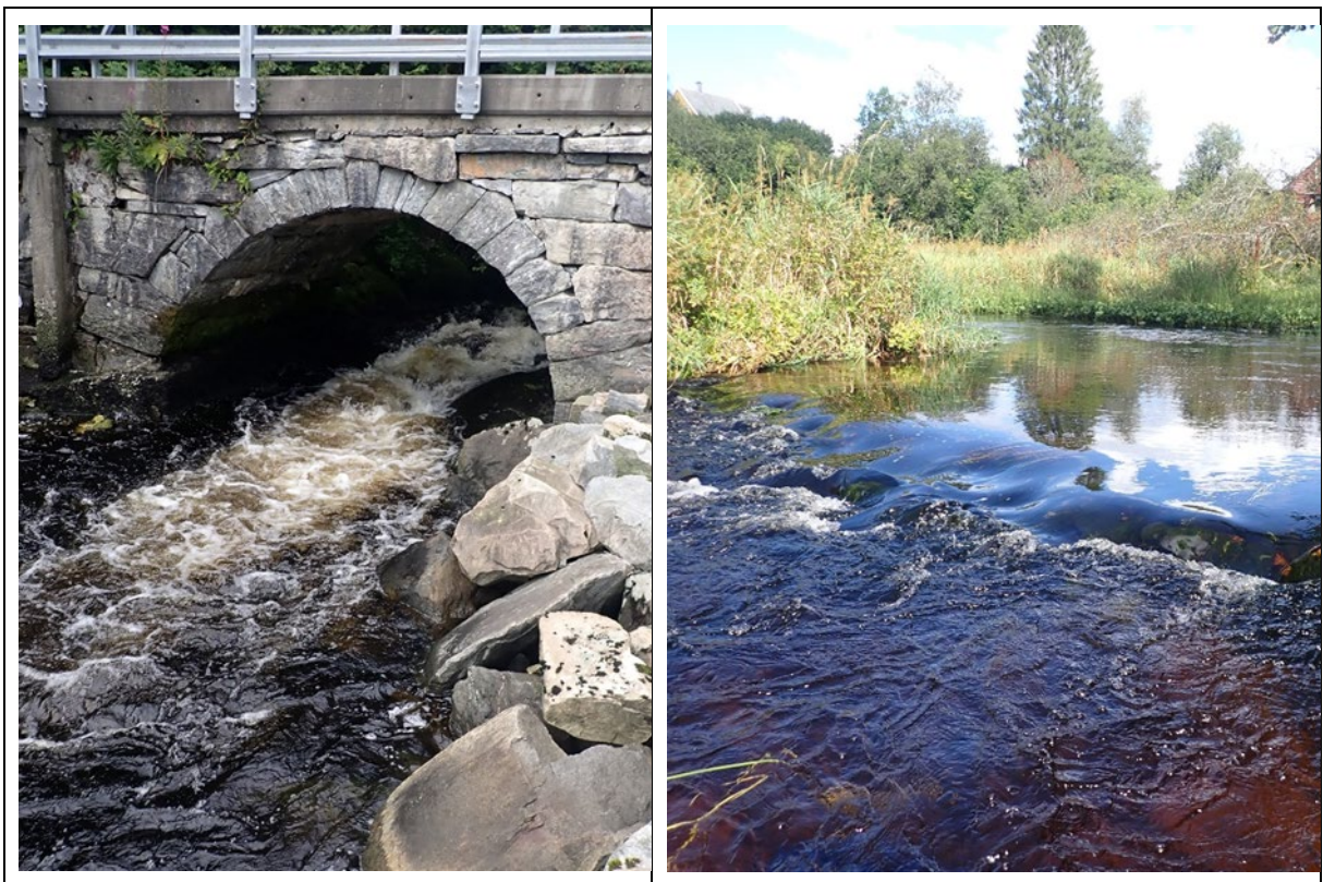
Nedre del av Eikangervassdraget med kulvert ned til sjøen (t.v) og kunstig terskel (t.h).
