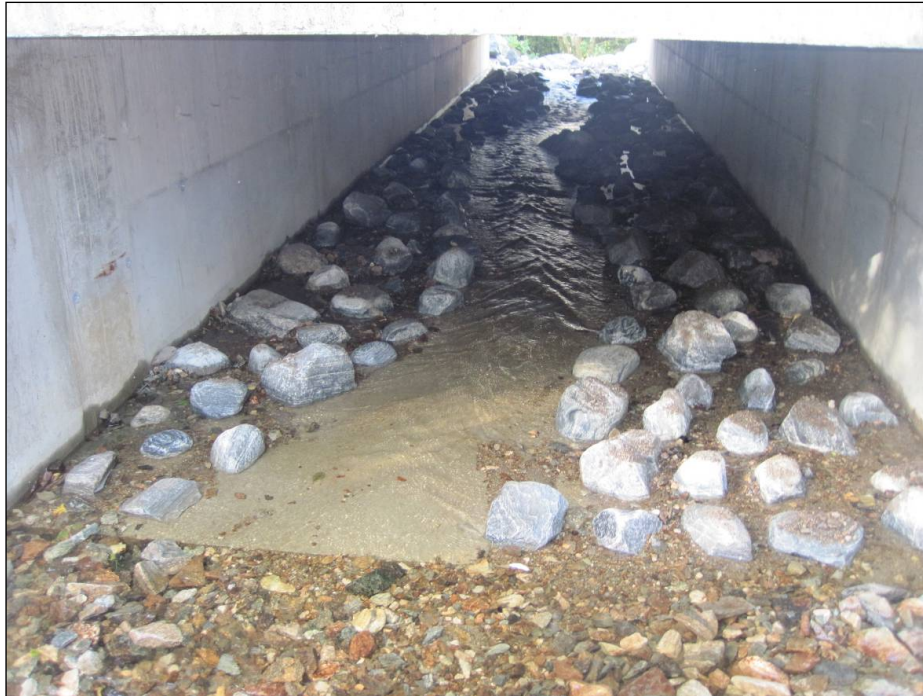
Figur 7. Bildet viser ny kulvert etablert i Apeltunvassdraget som ble sanert av Bergen kommune og som nå er passerbar for fisk igjen. Dette er et eksempel på et enkelt tiltak i kulvert med betongbunn. Etablering av strukturer, i dette tilfelle som steiner og dypvannsrenne, kan være nok for å sikre vandringsveien for fisk. Andre strukturer kan være ledebuner og terskler med lavvannsrenne.
