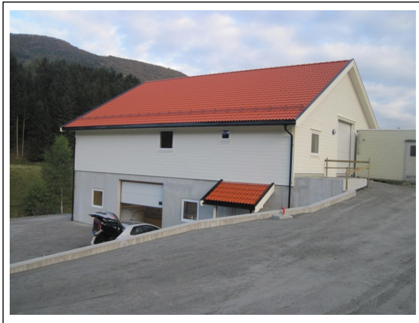
Det ble bygget et nytt stamfiskanlegg i Vikja i 2013.
