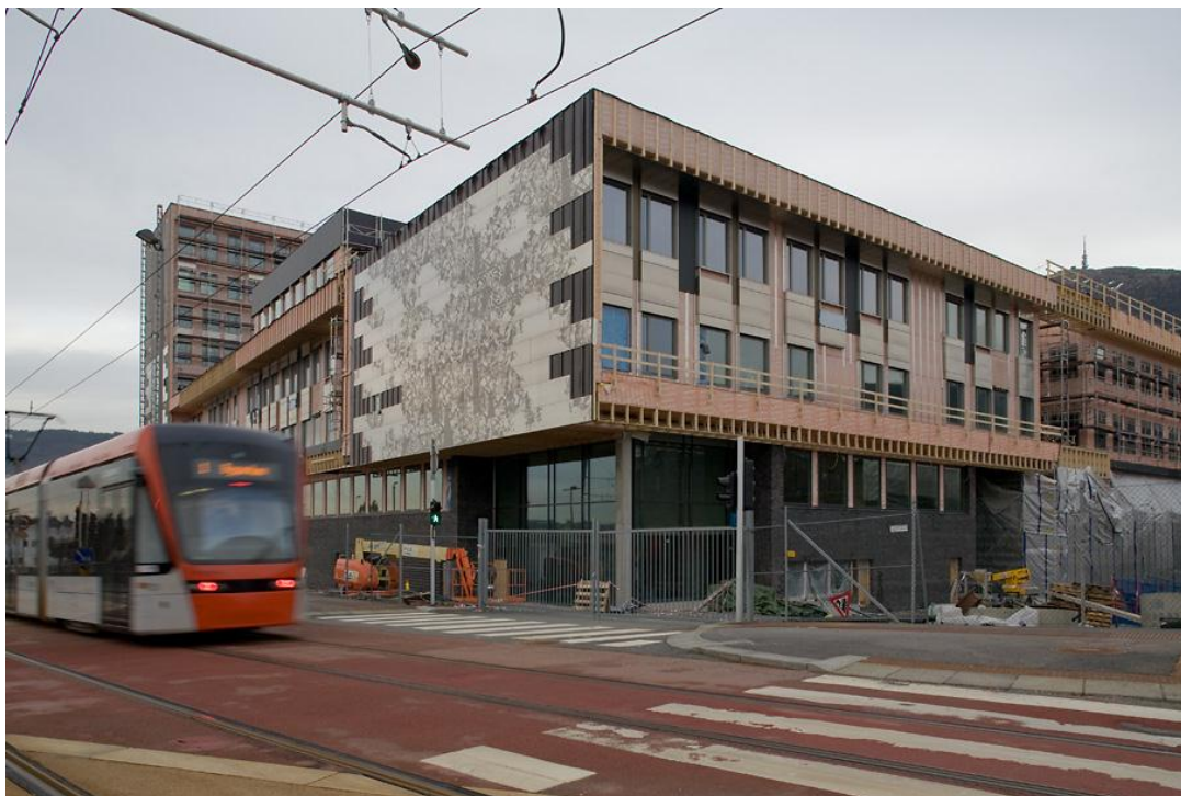
Figur 6. Høgskolen i Bergen under bygging inntil Bybanen ( www.hib.no )
