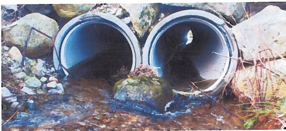
Figur 26. Nedre kulvert kan passeres av oppvandrende ørret gjennom venstre betongrør.
