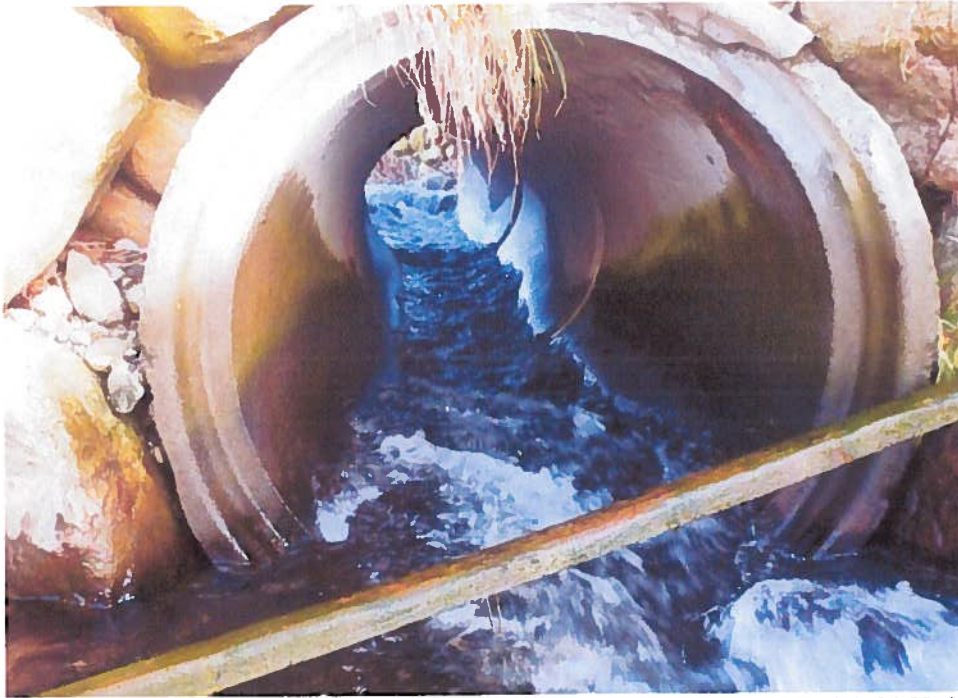
Figur 20. Vandringshindrende, men passerbar, betongkulvert (32 V 6526501 N, 317854 E) under vei anlagt ifbm masseuttak.
