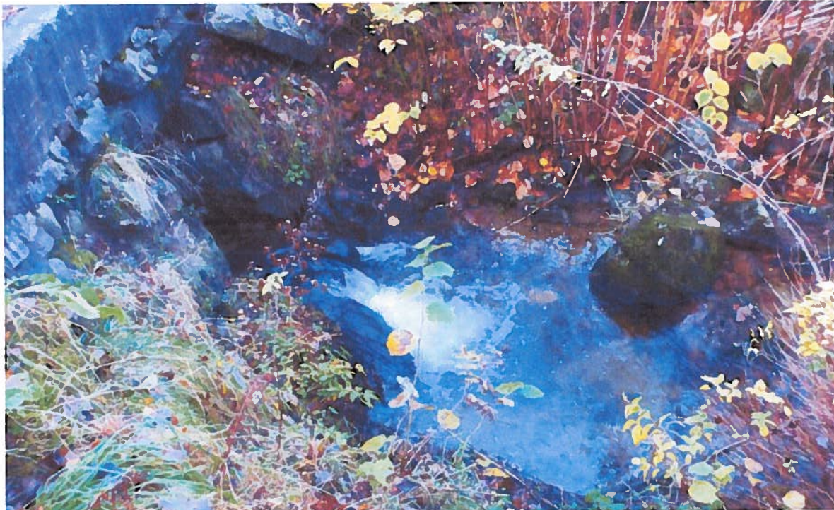
Figur 9. Veikryssning under Likaveien.
