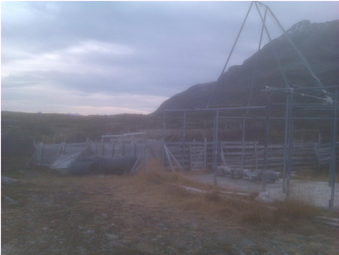
Vannøy reinbeitedistriktets slakteanlegg i Vannavalen
