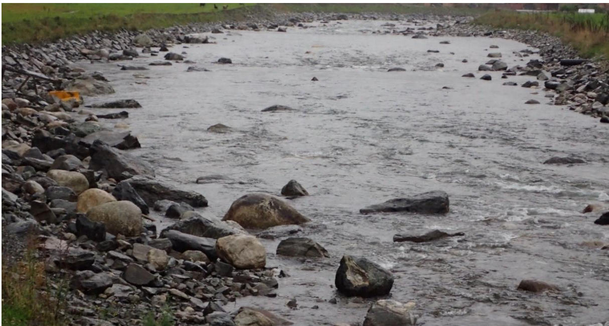
Figur 25. Tradisjonell erosjonssikring med glatt plastring (øvre bilde) og tilbaketrukket erosjonssikring med mer naturtypiske elvebredder (nedre bilde Flåm 2017).
