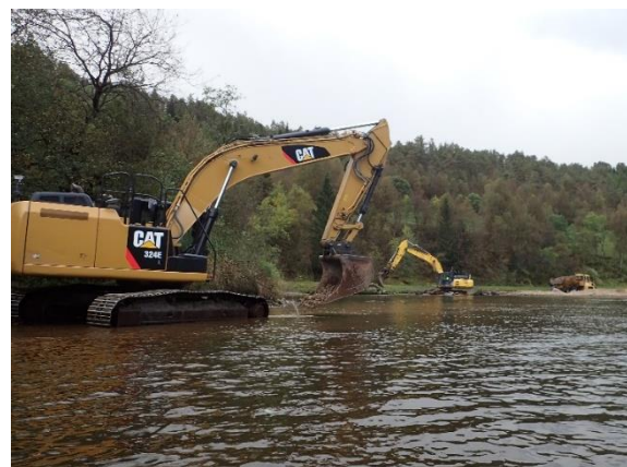
Figur 15. Bilder tatt under arbeidet. Venstre: Utgravede masser siktes i mobilt sikteanlegg. Høyre: Maskiner graver ut finsedimenter og legger tilbake ferdig siktede sedimenter.
