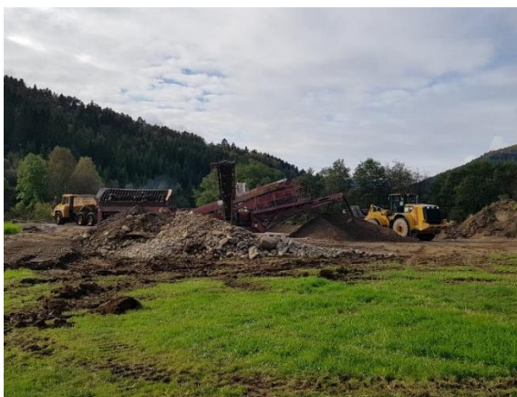
Figur 15. Bilder tatt under arbeidet. Venstre: Utgravede masser siktes i mobilt sikteanlegg. Høyre: Maskiner graver ut finsedimenter og legger tilbake ferdig siktede sedimenter.
