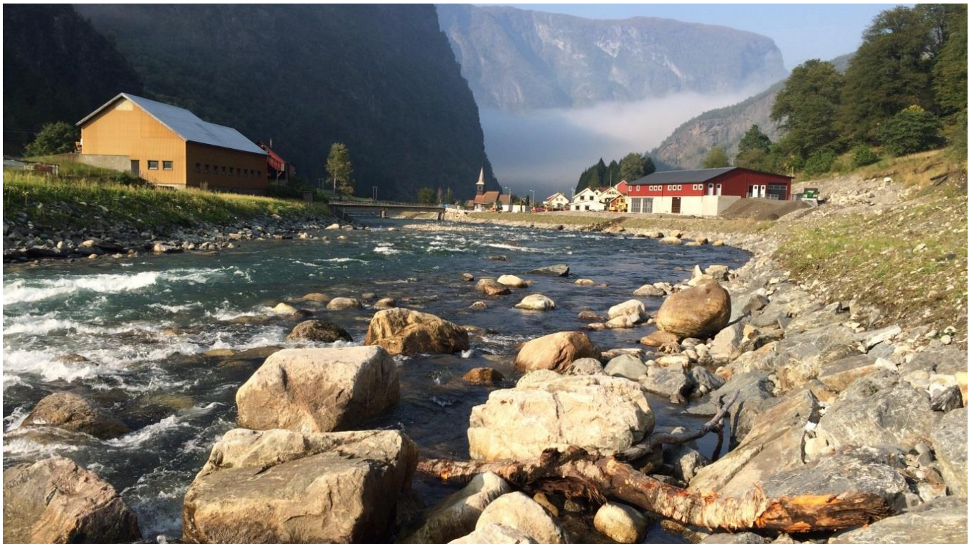
Figur 27. Flåmselvi ovenfor Flåm kirke. Bosetting krever erosjonssikring med stabil plastring langs yttersvingen. Foran plastringfoten ble det etablert en variert elvebredd med naturtypiske steinblokker og rullestein som gir habitat for fisk og sikrer plastringfoten ytterligere mot erosjon.
