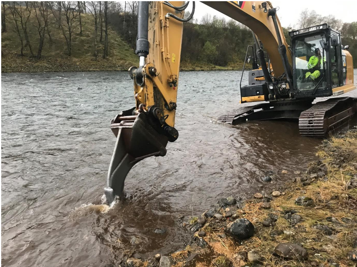
Figur 2. Fra gjennomføring av ripping ved Prestvika.
