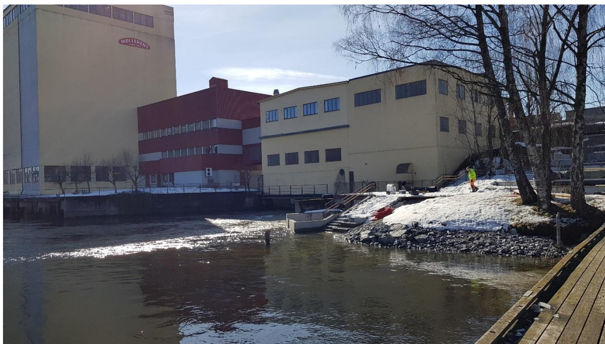
Figur 5. Skien kraftverk i Skienelva (Foto: Sebastian Stranzl)
