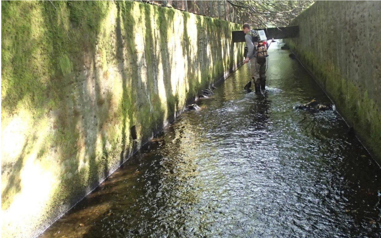
Figur 9. Sideløp og elveslette er ikke tilgjengelige for fisk når vassdraget er skjært inn i terrenget etter utretting eller der et er sterkt kanalisert
