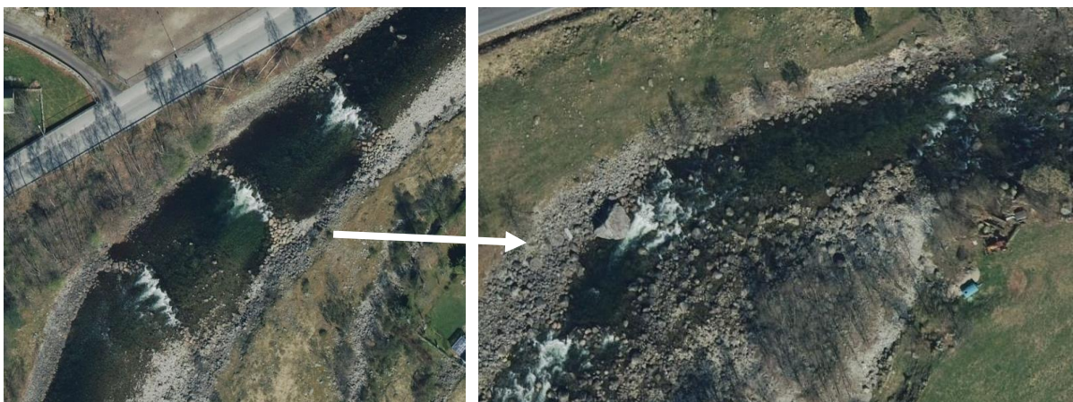
Figur 7. Det anbefales vedlikehold av terskelbassenger og omforming av terskler slik at det igjen utformes naturtypiske hølere og stryk. På bildene er dette vist for tersklene på Helle (venstre) som bør utformes som på bildet til høyre (Stolpehølen) 500 m ovenfor. Det samme gjelder terskel på Gabekk.
