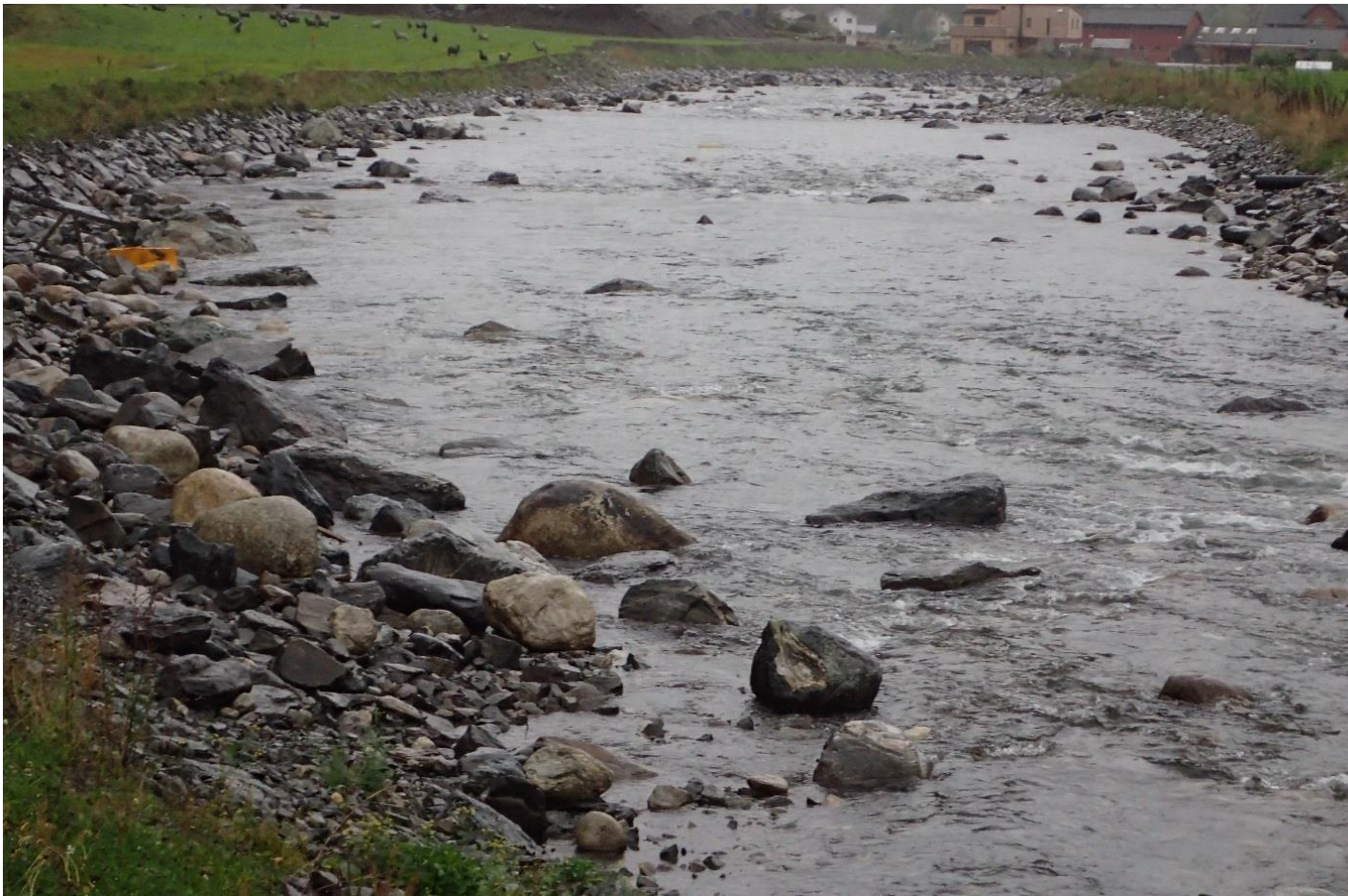
Figur 9. Tradisjonell erosjonssikring med glatt plastring (øvre bilde) og tilbaketrukket erosjonssikring med mer naturtypiske elvebredder (nedre bilde Flåm 2017 – kantvegetasjon mangler fortsatt).
