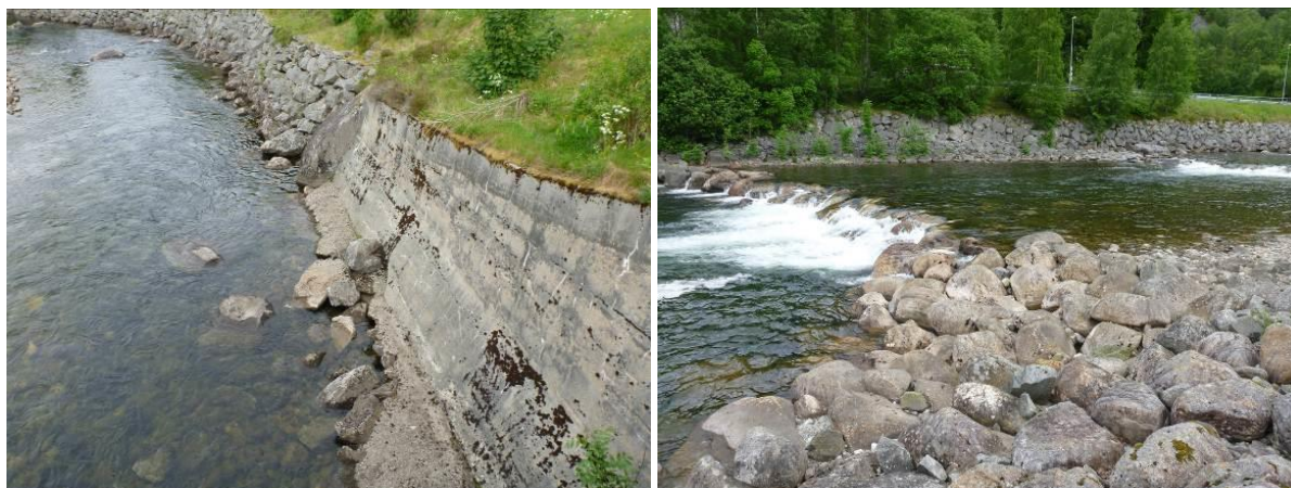
Figur 2. Forbygninger og terskler på Helle.
