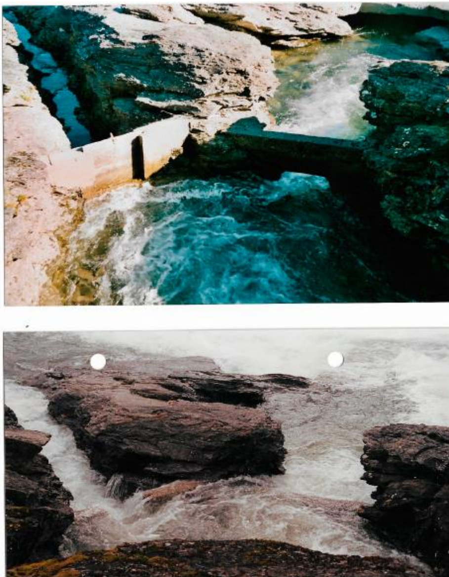
Fig. 58 Inngangene til trappa i Målselvfossen. På det nederste bildet vises det vanlige løpet til høyre og flominngangen til venstre. Det øverste bildet viser luka og inngangen fra Midtfallet i fossen, som benyttes når vannføringa i elva kommer under 60 \text{ m}^3/\text{s} og fisken kan gå et stykke opp i fossen. Foto: Helge Utby.
