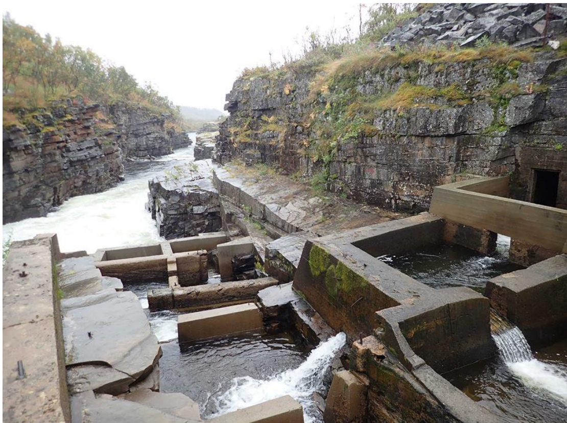
Fig. 45 Trappa i Førstefossen med redusert vannføring, med tunnelen så vidt synlig i høyre billedkant. Legg spesielt merke til det lagdelte berget.
