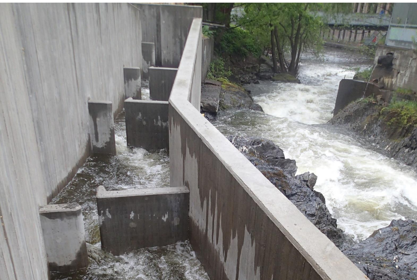
Spaltetrapp i Akerselva, anleggskostnad 7353 NOK/m 3 ombygget volum eller ca. 758.000 NOK per høydemeter (Foto: Ulrich Pulg).
