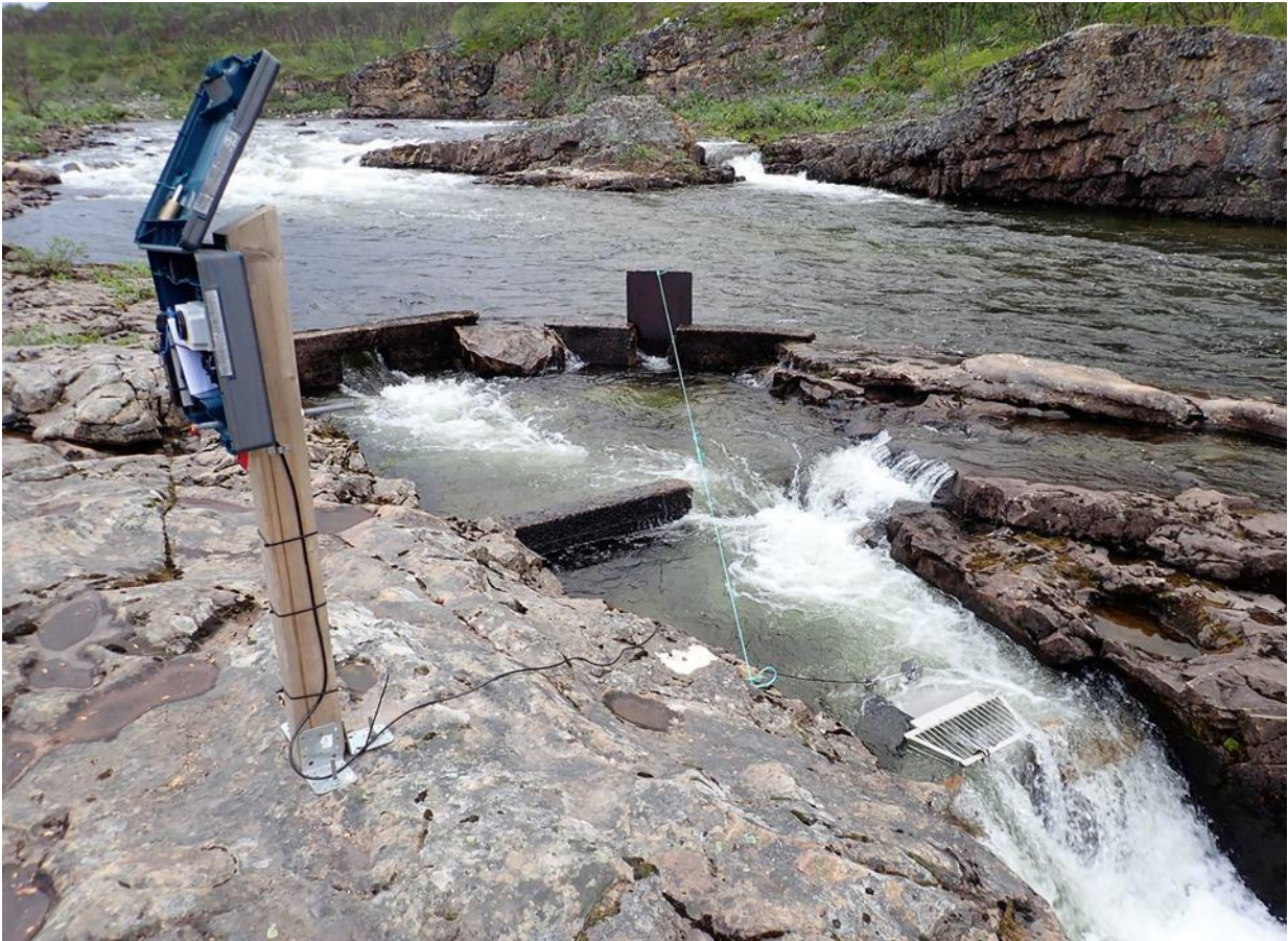
Fig. 47 Øverste del av trappa i Tredjefossen med tellesystem for oppvandrende fisk.
