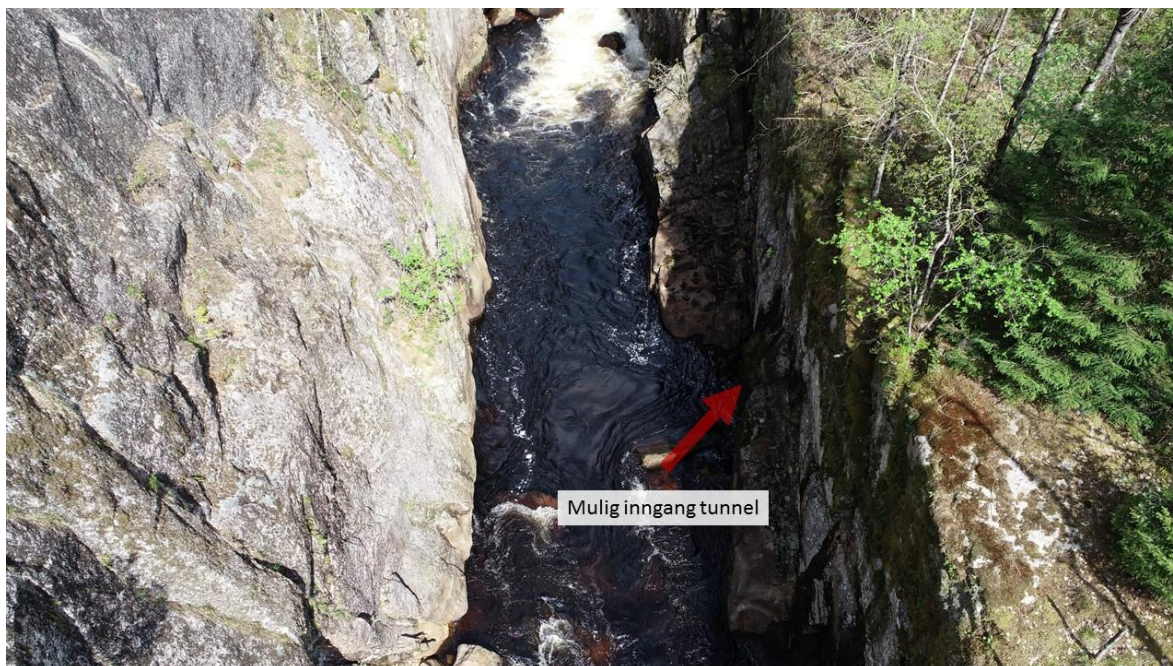
Figur 21. Potensielt sted for inngang til passasje gjennom tunnel. Stedet ligger like oppstrøms trinn 3 og man ser osen fra fossen i trinn 4 øverst i bildet.
