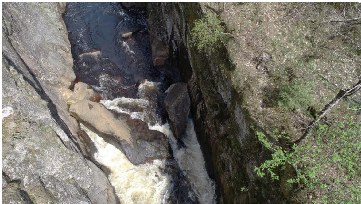
Figur 12. Dronebilde av trinn 3 tatt under oppmålingen med en vannføring på ca. 6.2 \text{ m}^3/\text{s} .
