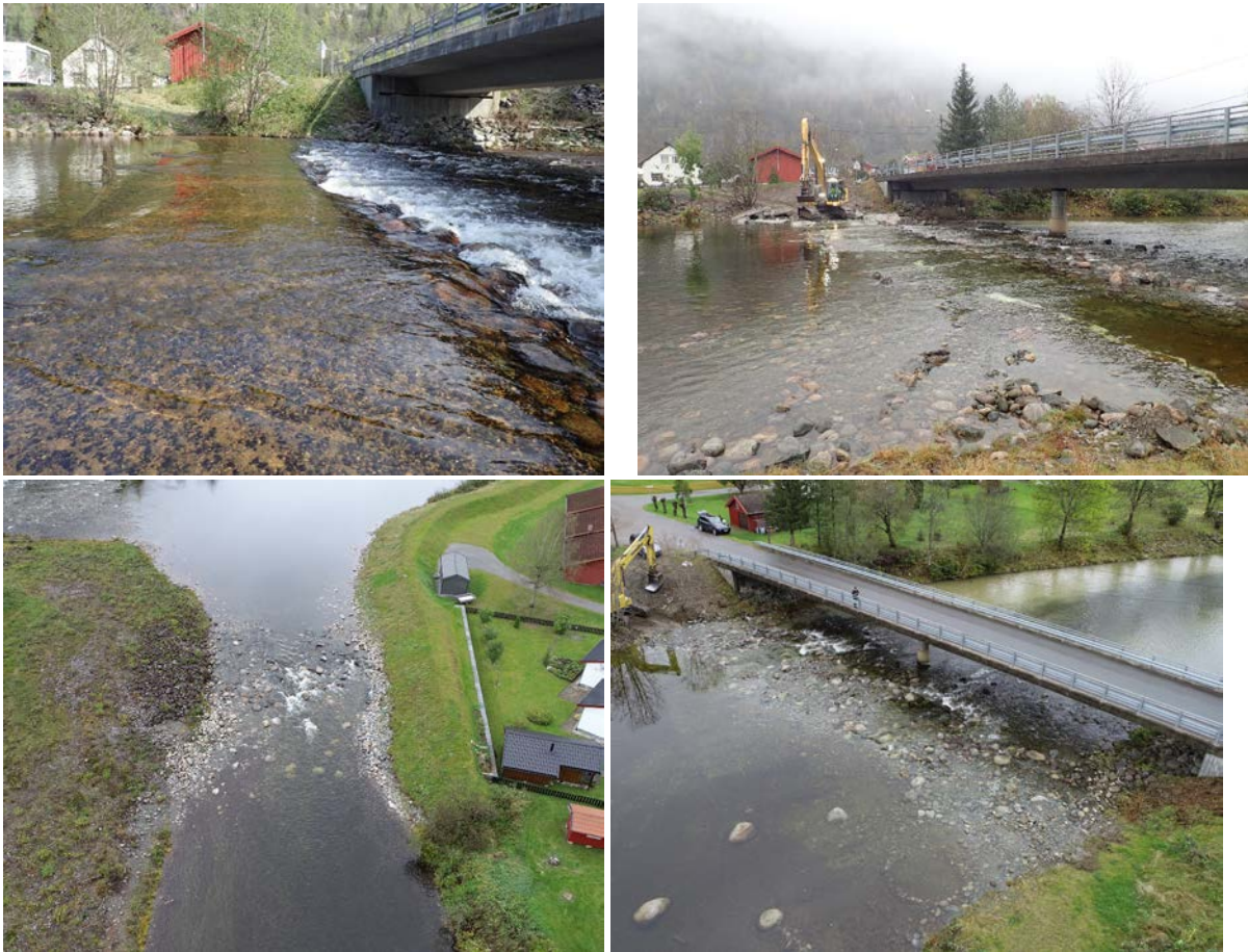
Figur 5. Øverst: Betongterskel ved veibro Buøyvegen før (venstre) og under (høyre) tilpasning. Nederst: Dronebilder av tersklene i løp ved Buøy etter tilpasning høsten 2019.
