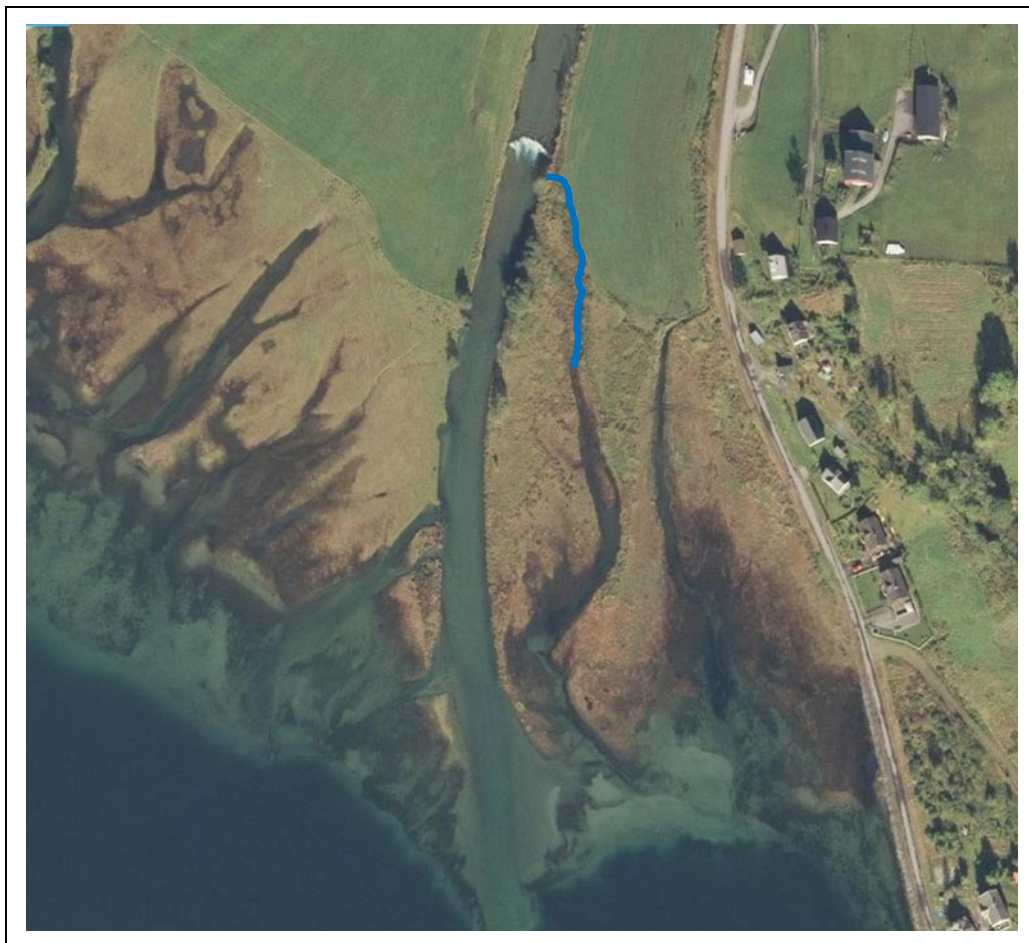
Figur 26. Sideløp i elvedeltaet ble gjenåpnet ved å lage en åpning i forbygningen i hovedelven rett nedstrøms terskelen og ved å grave ut et nytt løp i øvre del av sideløpet. Det ble lagt ut blokker i sideløpet for å skape bedre leveområder for ungfisk.
