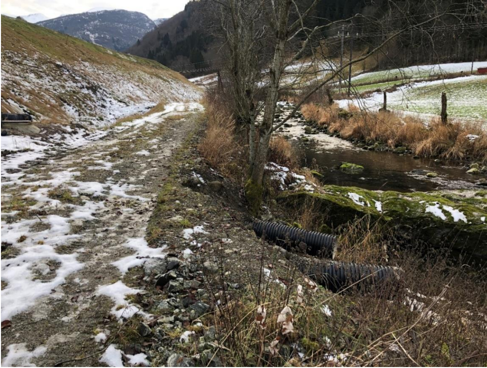
Figur 20. Vikja nedstrøms Hesjasletta. Vatn som renn over og gjennom deponiet vert drenert ut i Vikja etter reinsing av finsediment.
