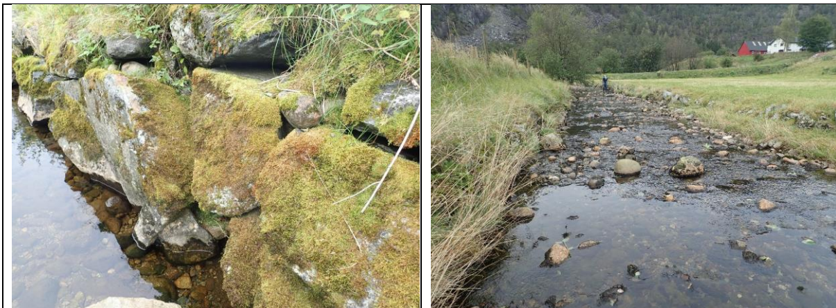
Figur 117. Eksempler på inngrep i Kvæstadbekken. Erosjonssikring (venstre) og fjernet kantvegetasjon langs breddene (høyre).
