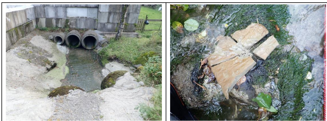
Figur 63. Rørene som går under Ølen Betong oppstrøms kulverten under Gullingvegen (venstre). Her var det ikke passerbart videre opp til Gardsbekken. Betongslam som ble funnet i elvebunnen i Kvepsabekken (høyre).
