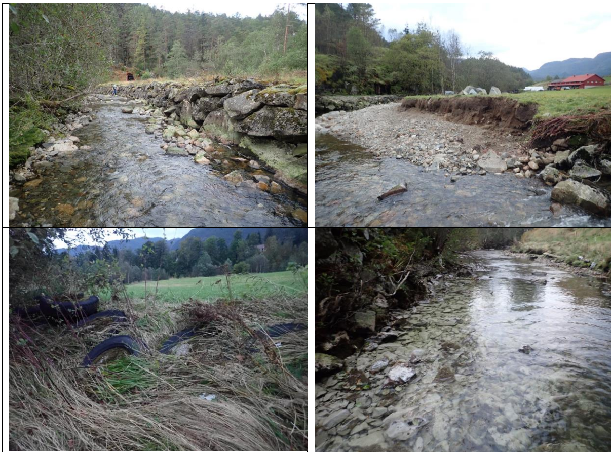
Figur 89. Eksempelbilder av inngrep og påvirkninger i Tjøstheimsåna. Øverst: Erosjonssikret elvebredden med til dels glatte steiner (venstre) og område hvor det var klargjort for å lage en ny sikring (høyre). Nederst: En merkelig løsning med å erosjonssikre elvebredden med rundt 20 bildekk fylt med betong (venstre) og utslippspunktet hvor det kom ut finsedimenter/sement (høyre).
