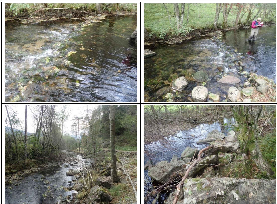
Figur 131. Eksempler på inngrep i Steinsåna. Øverst: Terskelen/vadesteinene som befinner seg omtrent midtveis i vassdraget. Nederst: Bilder fra et område i nedre halvdel av bekken hvor bredden er erosjonssikret med store blokker.
