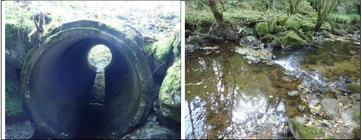
Figur 13. Røret som går under bilveien sett nedstrøms (venstre). Terskel nederst i kulpen før siste strykpartiet (høyre).
