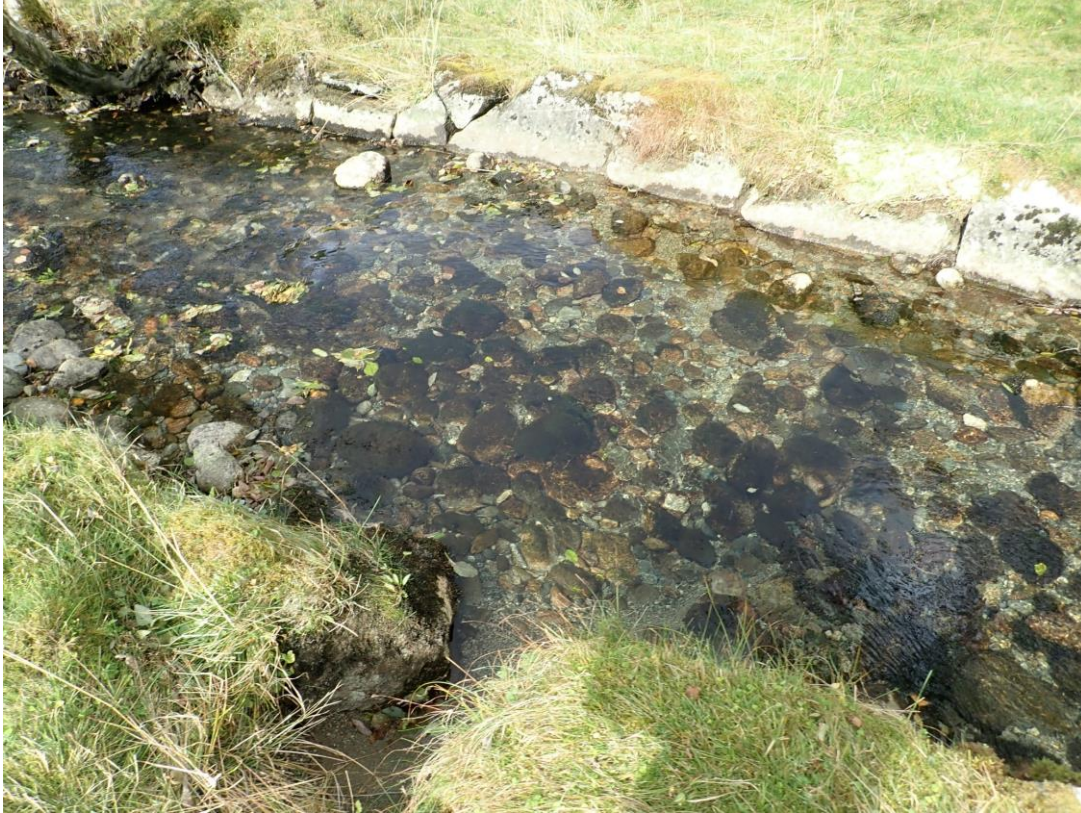
Figur 125. Erosjonssikring i midtre delen av Strapajuvet
