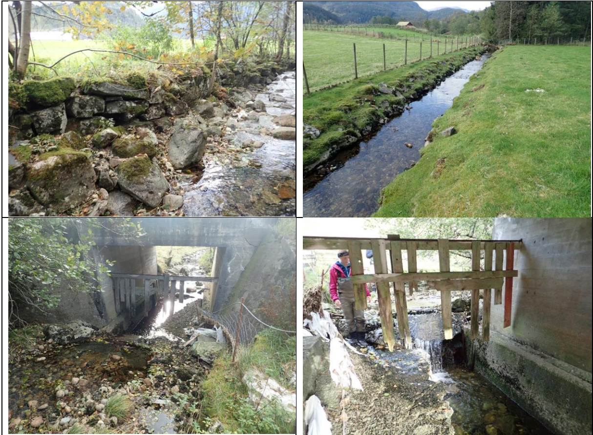
Figur 95. Eksempelbilder av inngrep og påvirkninger i Lundebekken. Øverst: Erosjonssikret elvebredde (venstre) og kanalisert strekning med fjernet kantvegetasjon på begge elvebredder (høyre). Nederst: Unaturlig fossefall ved kulverten under veibroen helt nederst i Lundebekken sett nedstrøms (venstre) og oppstrøms (høyre).
