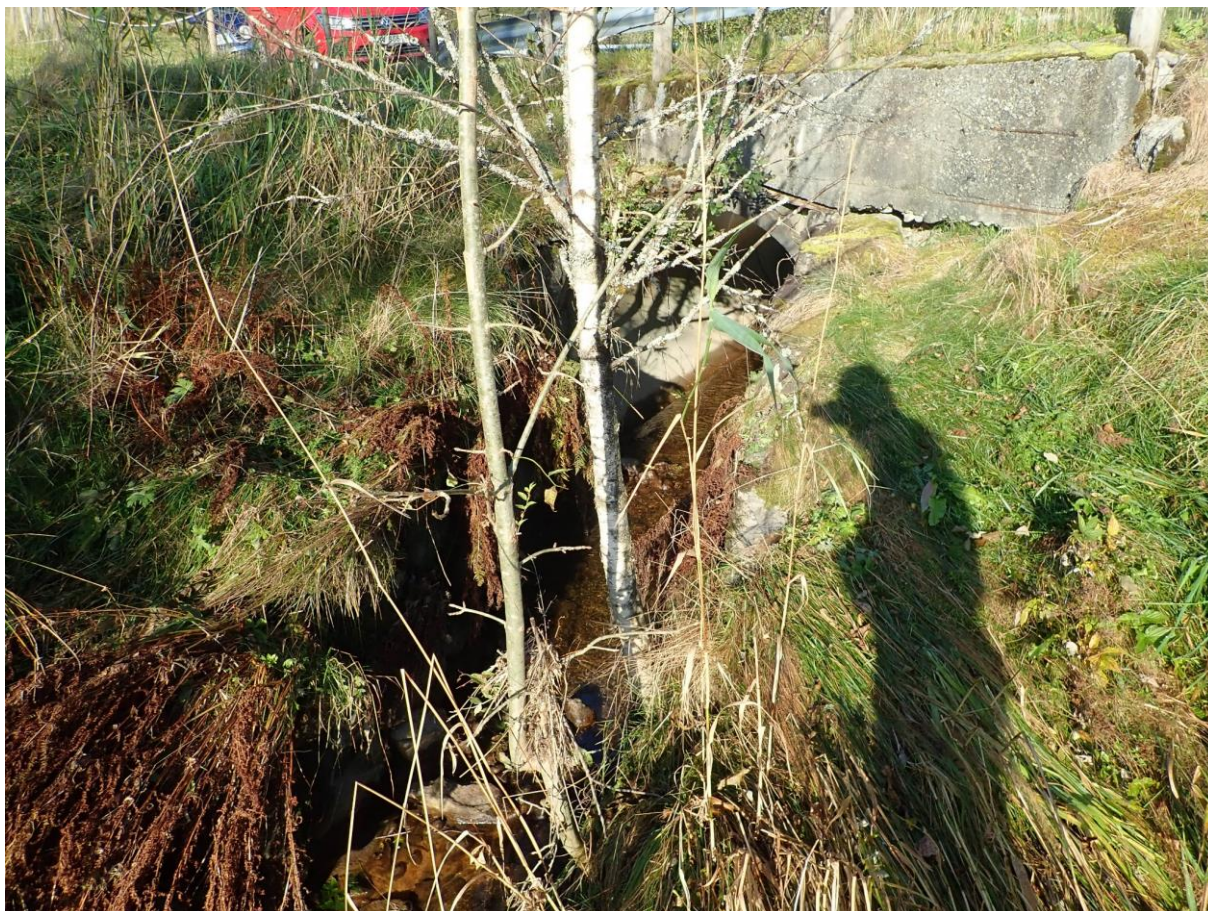
Figur 21. Her går Hanakamsbekken inn i rør/kulvert under veien.
