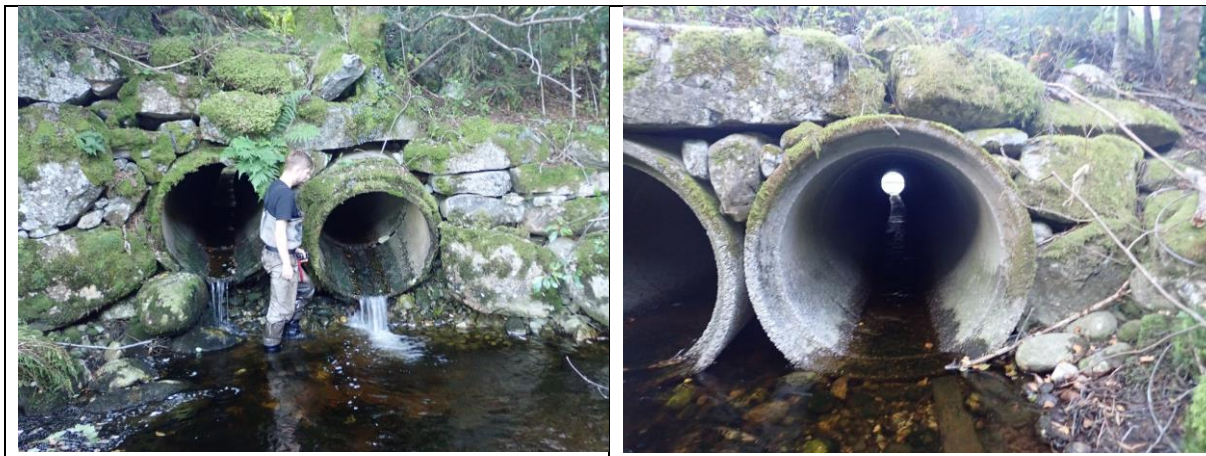
Figur 50. Rørene som går under Suldalsvegen er vannføringsavhengig vandringshinder for oppvandrende laks og aure.
