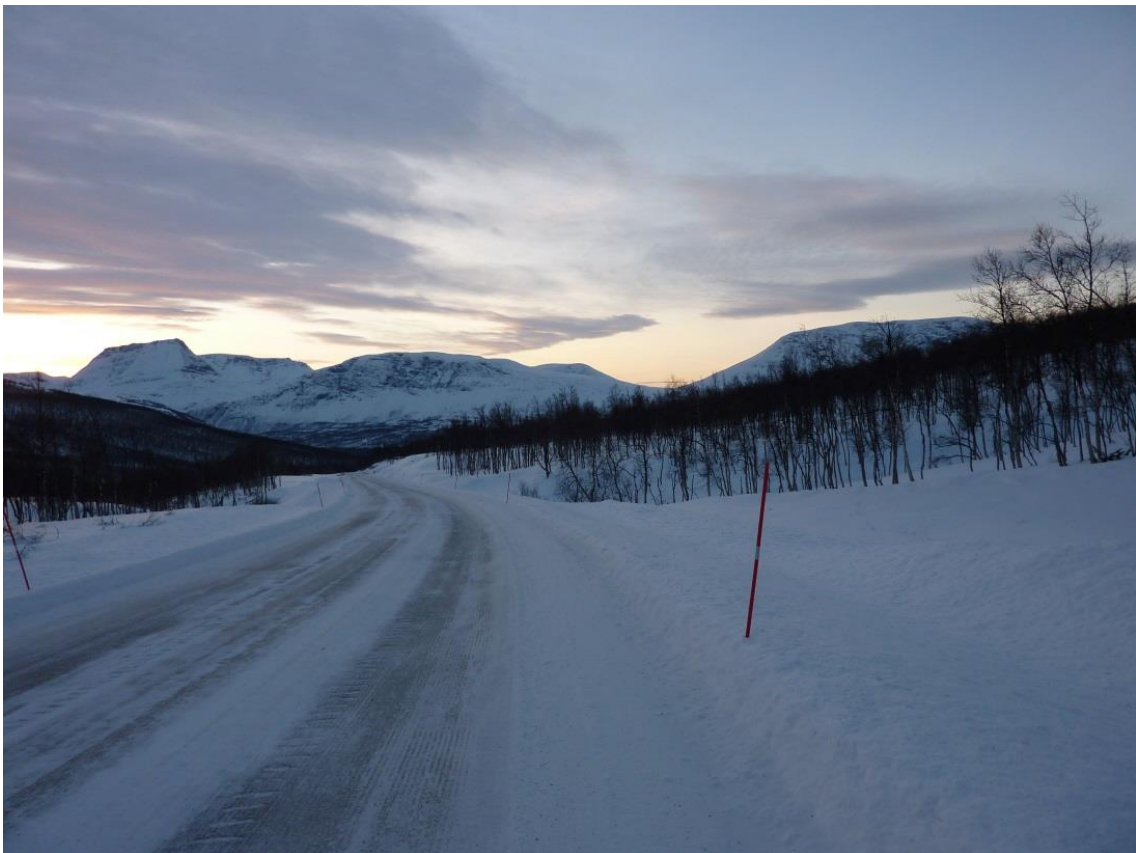
Figur 13. Området mot Tverrelva sett fra nord. Rekkverk vises ikke på bildet. Foto: I.E.Danielsen
