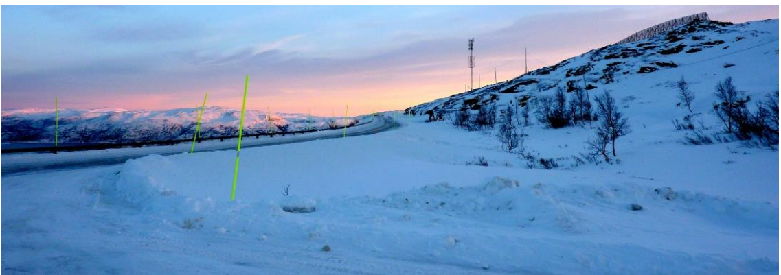
Figur 18. Avkjørsel nord for Gildetun. Vegen sett nordover mot Vegdalssvingen. Foto: I.E.Danielsen.
