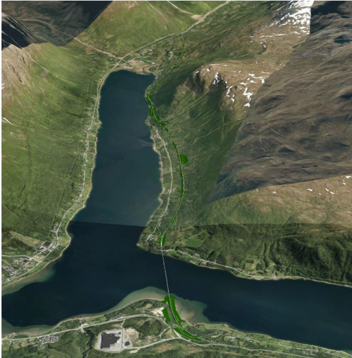
Figur 27. Ny veitrasé lagt inn i terrenng (Statens vegvesen 2020)
