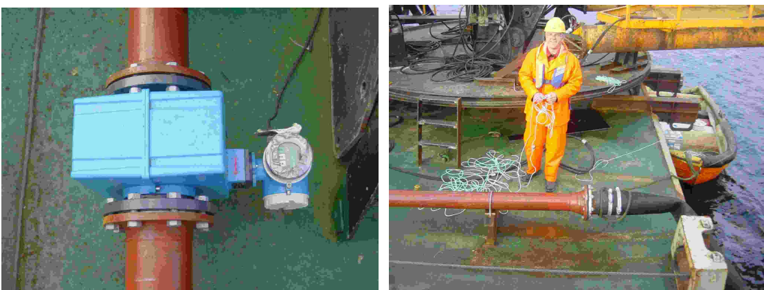
Figur 3.6. Til venstre måleinstrument for utleggingshastigheten, til høyre overgang fra fast rør til fleksibel sjøledning ut til pæleføringen.
