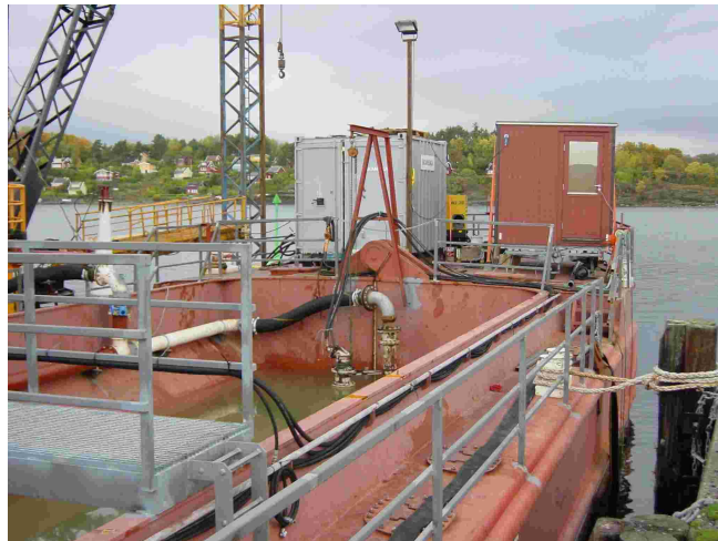
Figur 3.2. 300 m 3 lekter sett mot slampumpen i enden av lekteren
