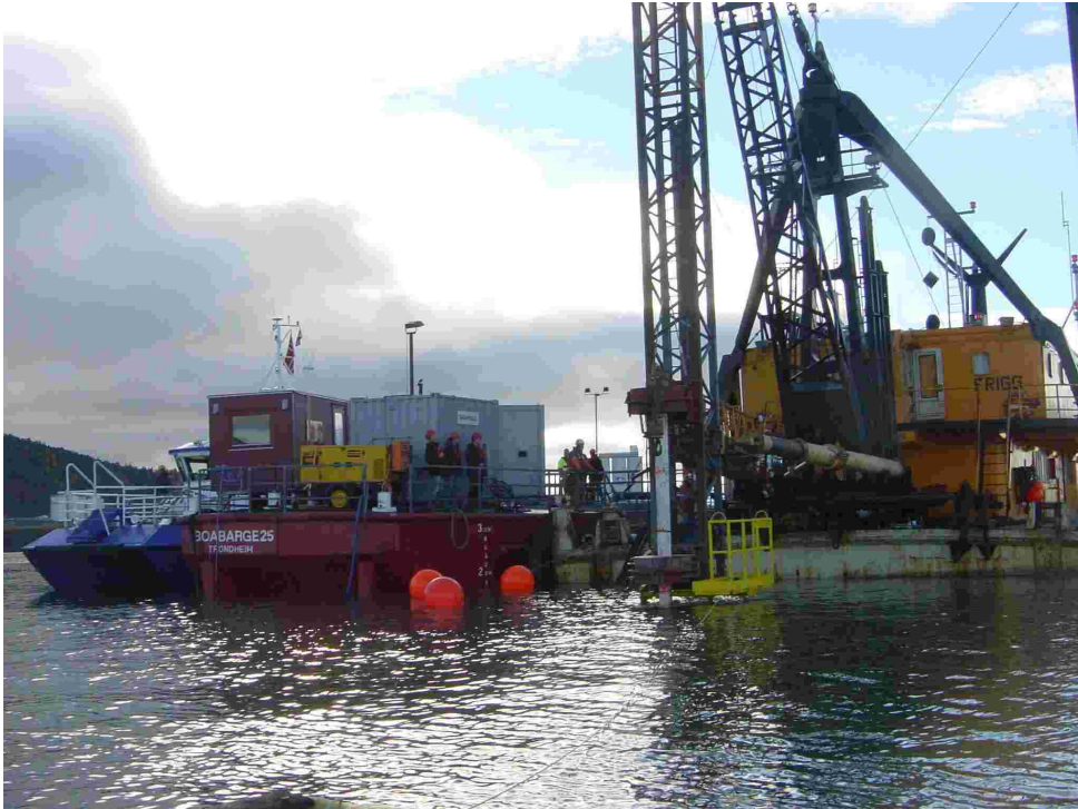
Figur 3.4 Utleggerfartøy sett mot front. Pæleføringen med rør ses i front av fartøyet. Til venstre for fartøyet ligger lekteren fortøyd og klar til pumping av masse. Helt til venstre i bilde ses havnevesenets sightseeing båt.
