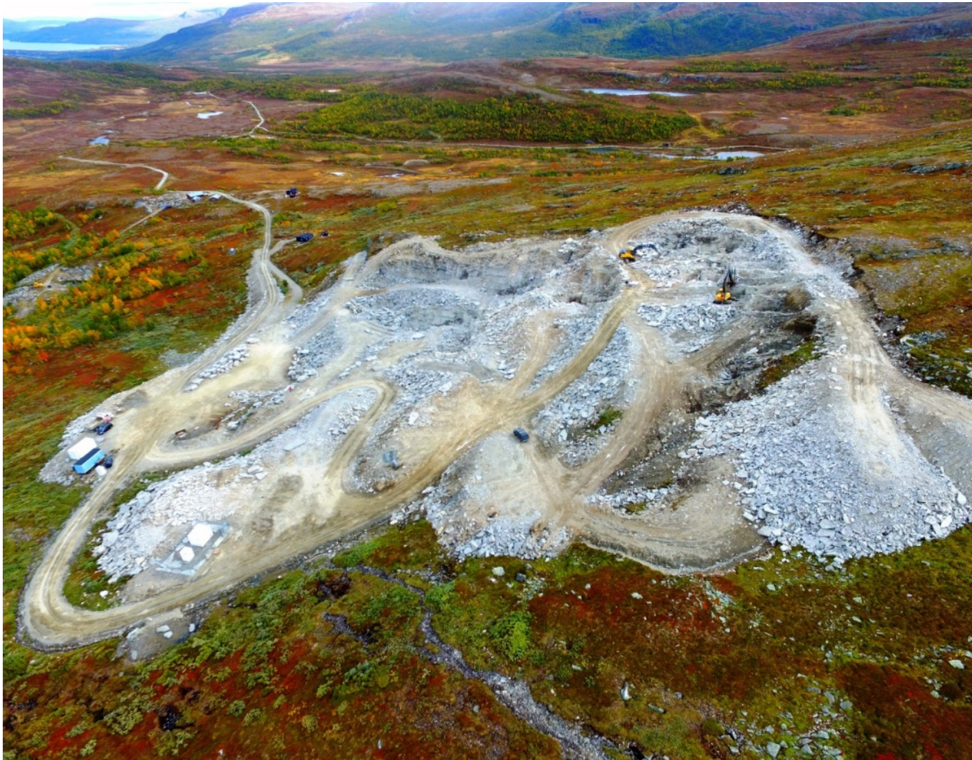
Figur 25. Sett mot NØ. Dronebilde fra befaring 12.09.2017 (Sletten 2017).
