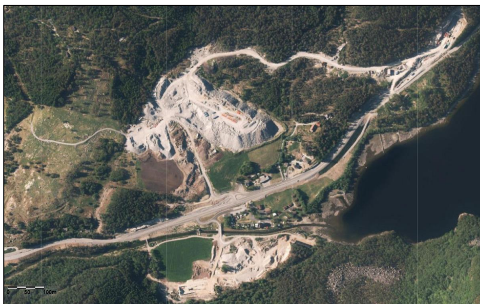
Figur 7: Anleggsarbeid og grustak ved utløpet av Tysdalsvatnet. Bilde fra 2013 (norgebilder.no)
