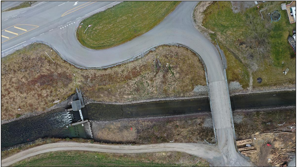
Figur 18: Damsluke 350 m nedstrøms utløp fra Tysdalsvatnet
