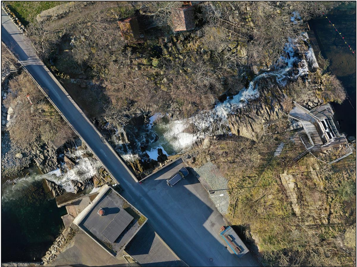
Figur 16: Dam og bratt vannfall over berg ved nordlig utløp fra Krossvatnet
