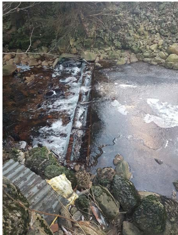
Demning oppstrøms Øyan. Demning bør fjernes.
