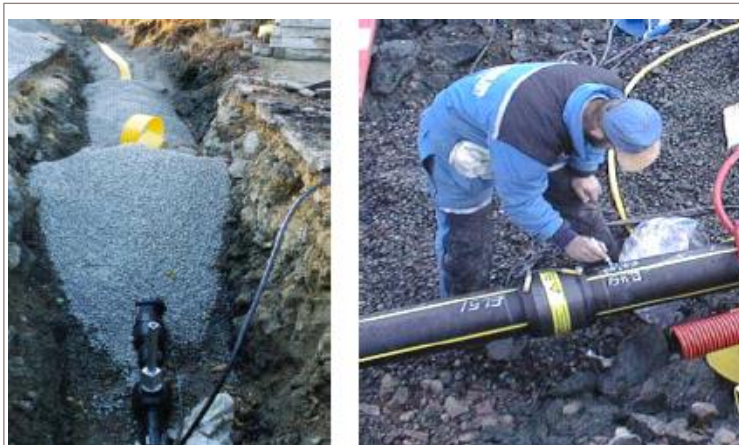
Figur 10 - Legging av rør for naturgass
