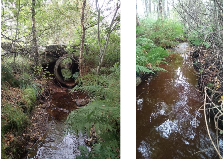
Figur 7. Stasjonen HÅL-STA. Til venstre: Mot vei (nordover). Til høyre: Mot utløpet til Hålandsvatnet.
