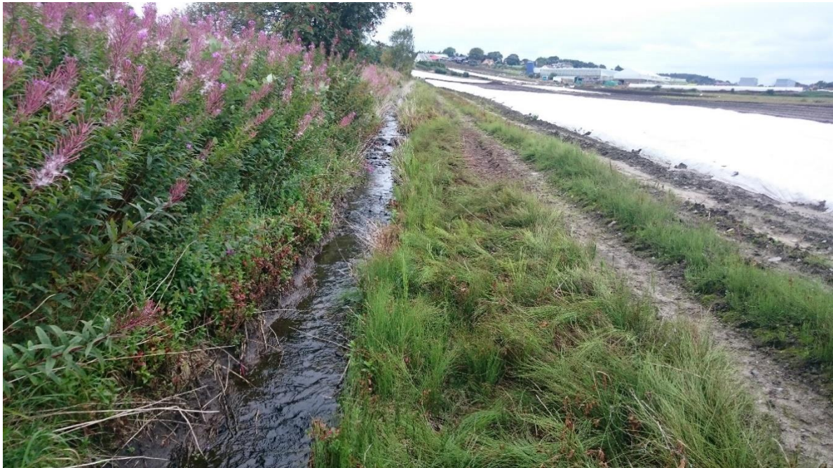
Figur 6. Oversiktsbilde fra stasjonen HÅL-RAN.
