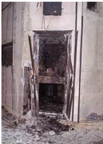
Figur 5.2: Et av tilfluktsrommene etter brannen i Mont Blanc tunnelen
