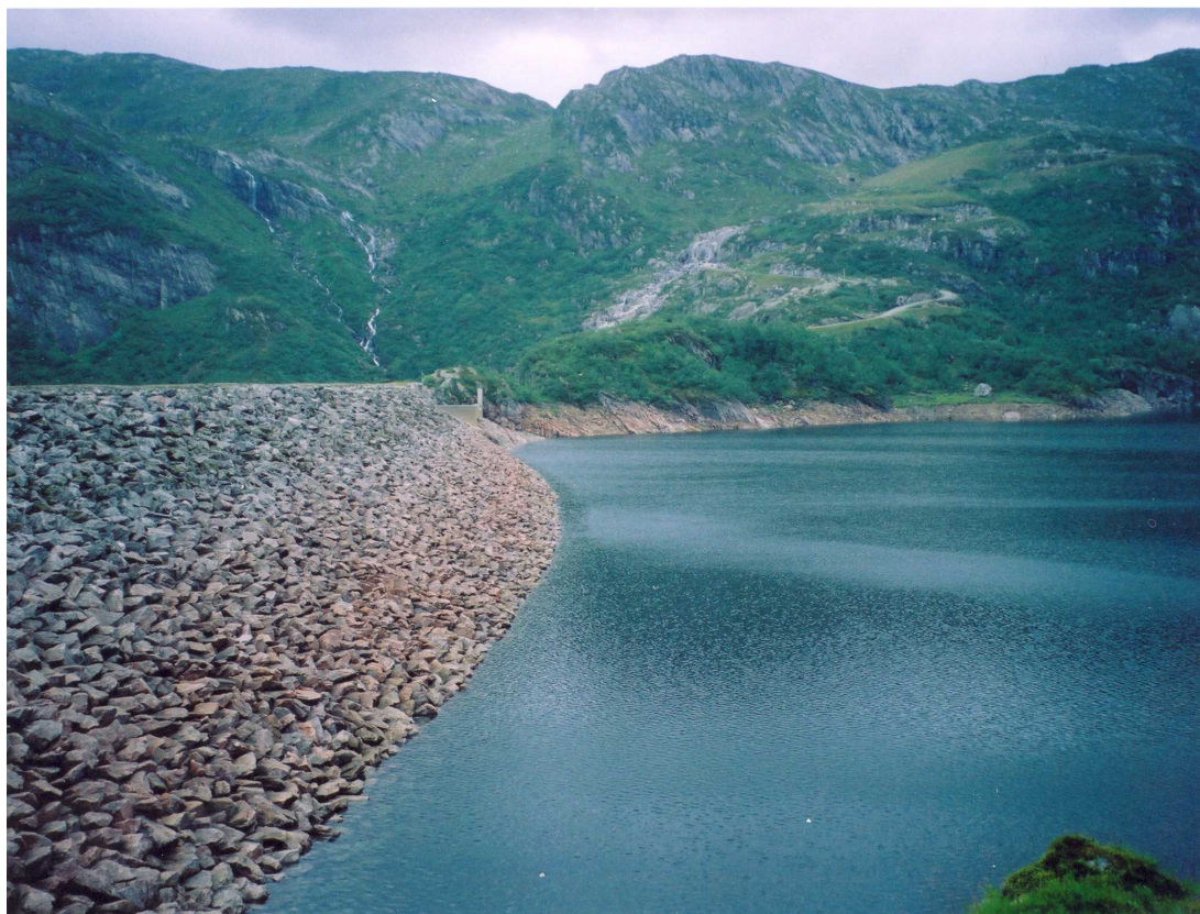
Figur 2. Stølsvatnet. Dammen sett fra sør.
