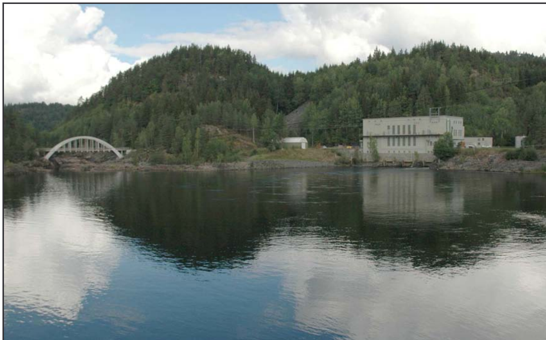
Iveland kraftstasjon sett fra broa ved Kattfossen. Elveløpet kommer ned under broa til venstre i bildet (foto: Helge Skoglund).
