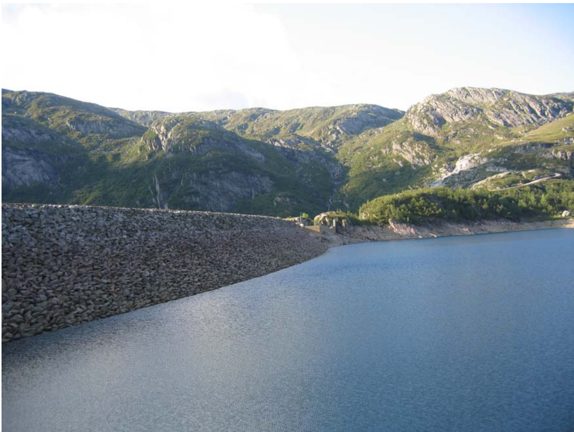
Figur 2. Steinfyllingsdammen i Stølsvatnet.
