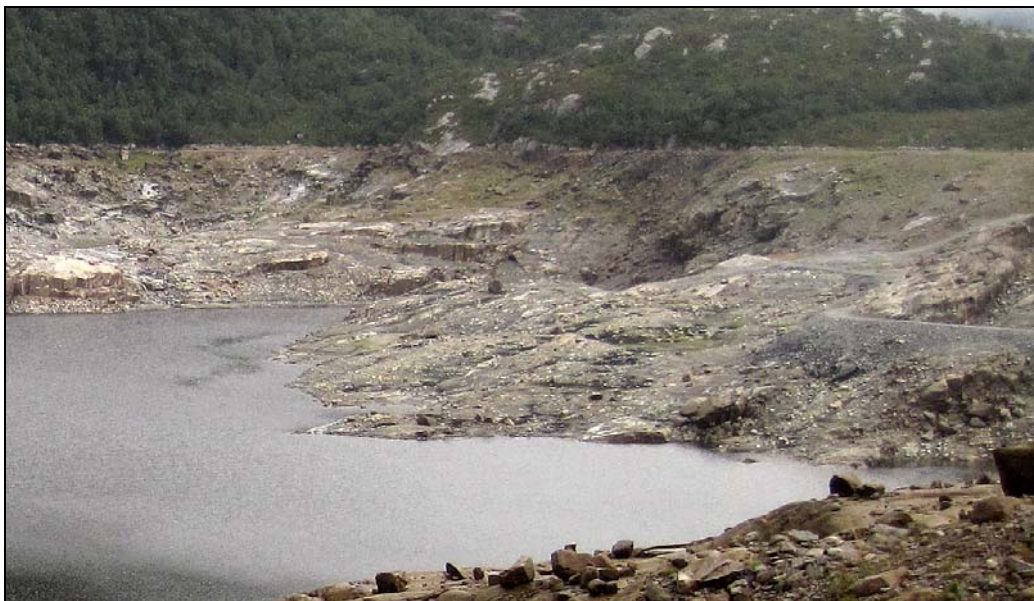
Foto 1: Vannstanden i Kløvtveitvatnet 31.08.10. Anleggsveien ses til høyre i bildet.
