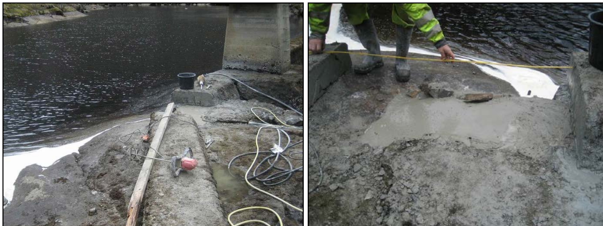
Utsparing (LxD = 160 x 30 cm) i betongterskelen ved dammen på Tveito, våren 2011.
