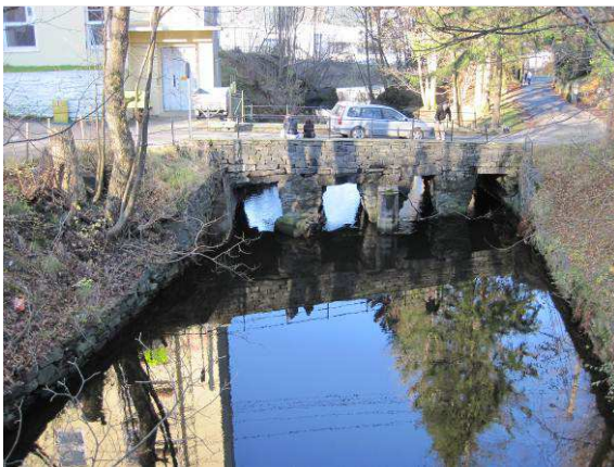
Figur 8 Nesttunelven mellom Hopsvannet og Nesttunvannet. Store deler er kanalisert og forbygget.
