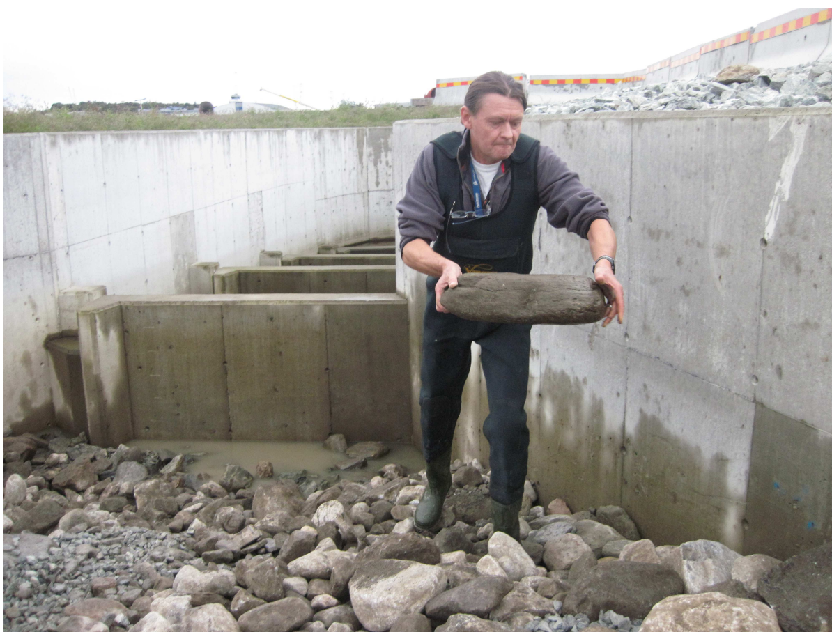
Figur 51 Terje Aarsand (Avinor) ved bygging av fiskepassasjen under rullebanen.
