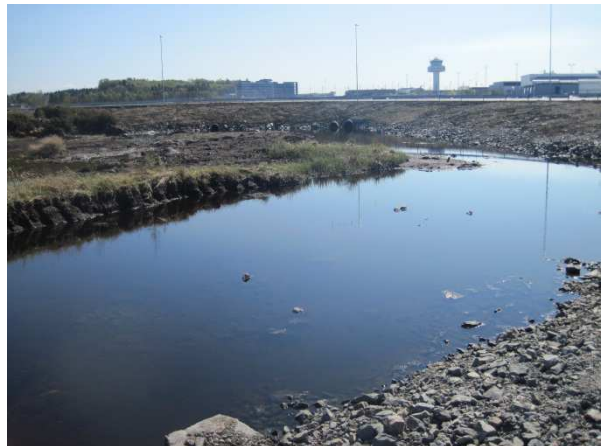
Figur 32 Rester av Skjenavatnet og en del av Fleslandselven som er lagt i rør (kulvert i bakgrunn).
