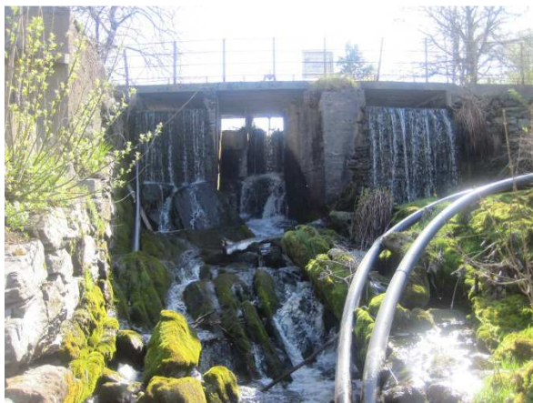
Figur 23 Demningen som stuer opp dammen nedenfor Fleslandveien, vandringsbarriere for sjøaure.
