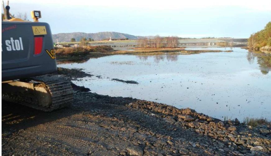
Figur 4 Langavatn sør. Stasjon for vannplanter. Bildet er tatt 27.11.2012. Anleggsarbeid pågår i området.
