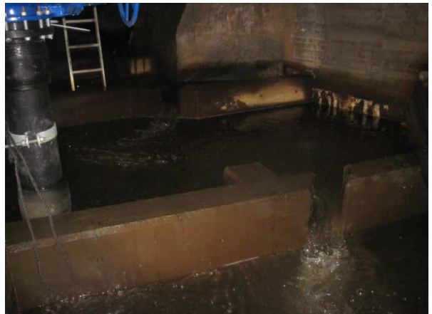
Figur 28 Fiskepassasje i kulvert under rullebanen.
