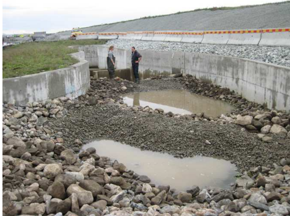
Figur 29 Innløp av kulvert under rullebanen med fiskepassasje, gyteplasser og ungfiskhabitat (under bygging 2012, sett fra Langavatnet).
