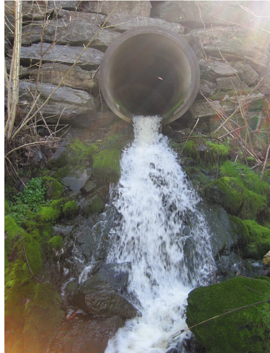
Figur 49 Kulvert under Fleslandsveien.
