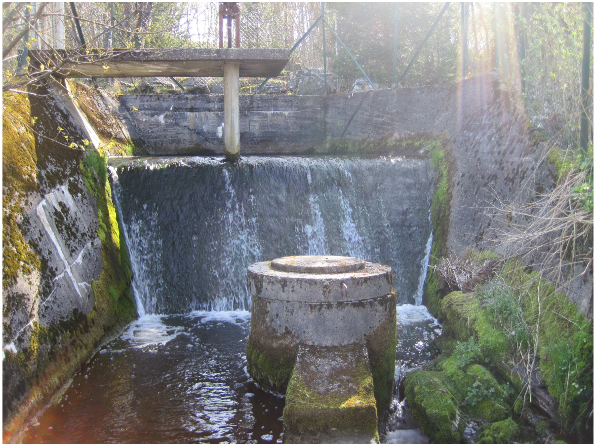
Figur 50 Betongterskel ved inngang til kulvert under rullebanen.
