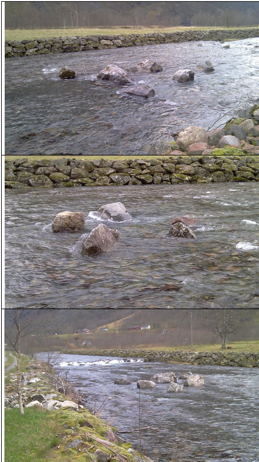
Bilde 8. Steingrupper lagt ut i samløpet i Osa i 2011. Bilder fra Statkraft.
