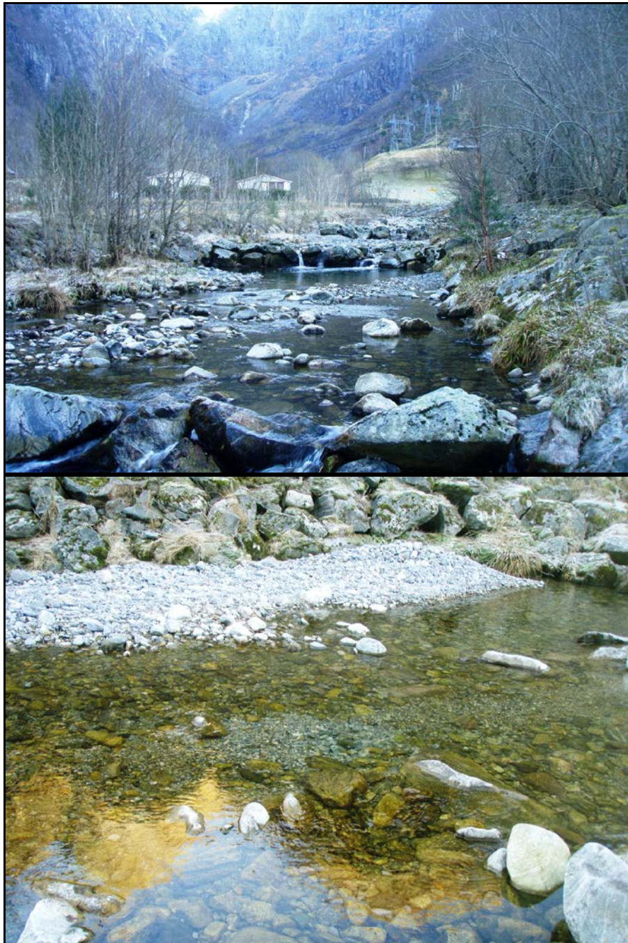
Bilde 14. Øverst: Område i nedre del av Austrepollelva hvor det er laget en rekke mindre terskler, flere av disse fikk skader under flommen høsten 2010, og noen kulper nedstrøms tersklene har blitt grunnere etter tilførsel av løsmasser. I dette området har det årlig blitt observert fisk under gytefisktelling (Foto: LFI Uni Miljø v/Ole R. Sandven). Nederst: Gytegrep på utløpet av en av tersklene. Gytegropen fremkommer som det lyse feltet midt i bildet (Foto: LFI Uni Miljø v/Ole R. Sandven).
